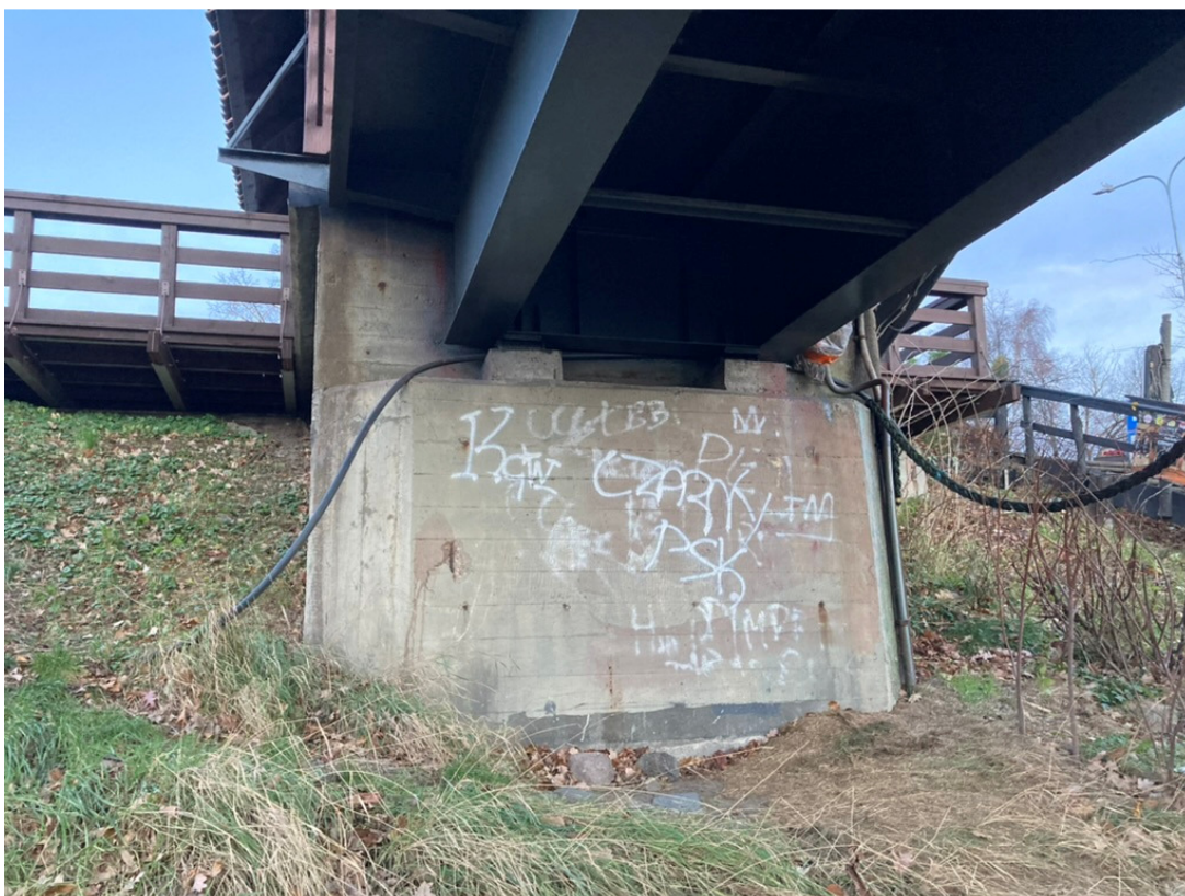
Fotografia nr 6 – Widok przyczółka od strony Kałdowa
