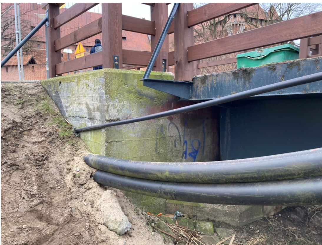
Fotografia nr 7 – Widok przyczółka od strony Malborka
