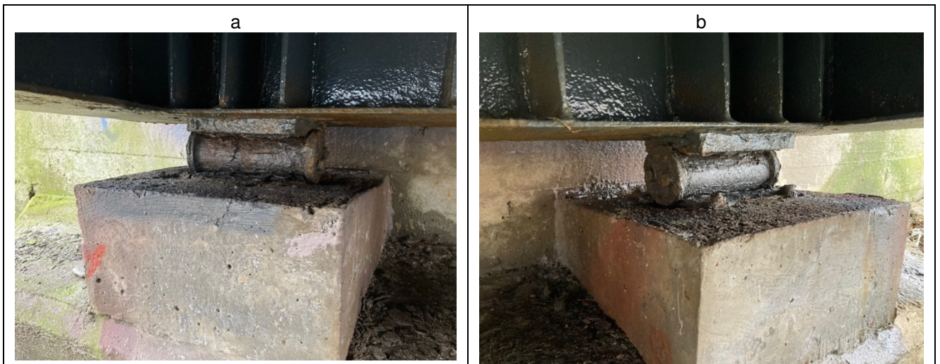
Fotografia nr 9a,b, – Łożyska wałkowe na przyczółku od Kałdowa.
