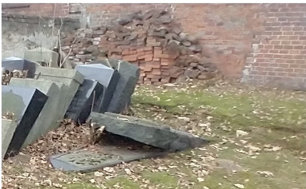
Fot. 10. Gromadzona cegła bezpośrednio przy ścianie.
