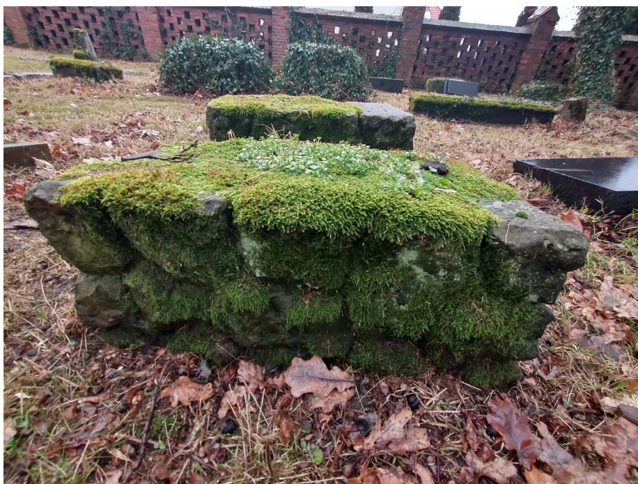
Fot. 19. Postumenty porośnięte mchem i/lub bluszczem.
