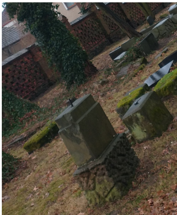
Fot. 18. Uszkodzenia i zabrudzenia na powierzchni kamienia.
