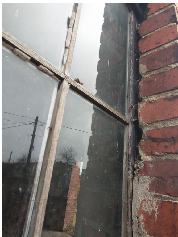
Fot. 5. Ubytki w cegle i spoinie wokół okien.
