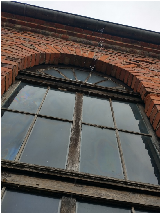
Fot. 3. Nieszczelne orynnowanie.
