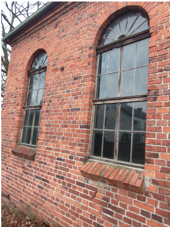
Fot. 4. Parapety pokryte mchem i zawilgocenie przyziemia.
