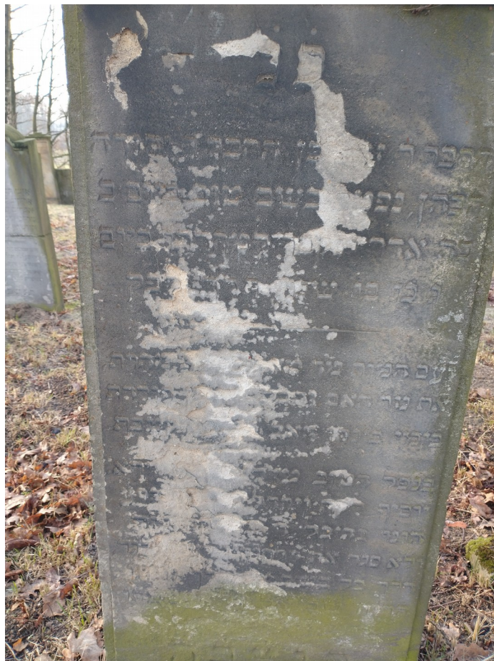
Fot. 22. Zabrudzenia i zniszczenia na powierzchni płyty z piaskowca wraz z zatarciem inskrypcji.
