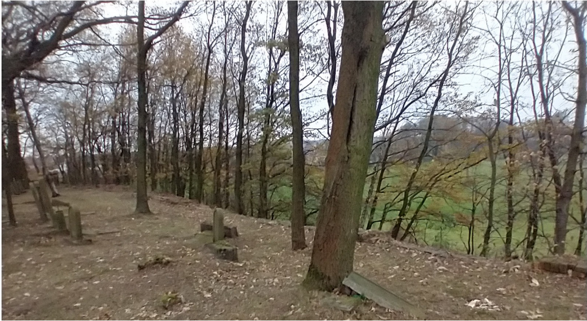
Fot. 13. Brak ogrodzenia od strony zachodniej.
