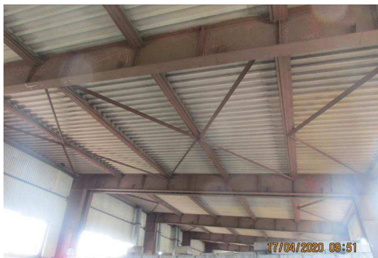
Fot. 5 Stalowa konstrukcja nośna budynku.
