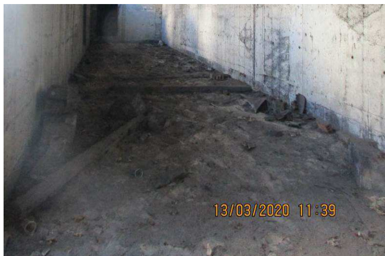
Fot. 1 Zасыпка piaskowa płyty fundamentowej wewnątrz obiektu
