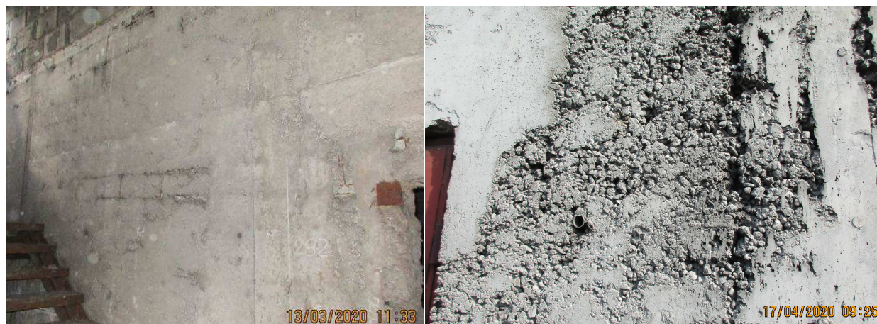
Fot. 3a i 3b Widoczne wady betonu: przebijające zbrojenie i złe zagęszczenie mieszanki betonowej
