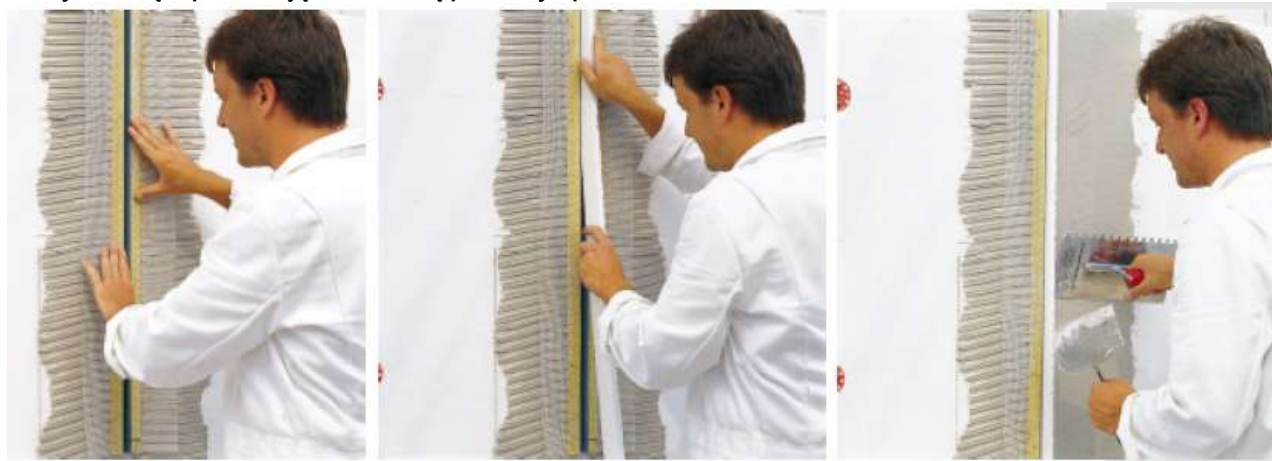
Rys. 20. Schemat układania profilu dylatacyjnego
