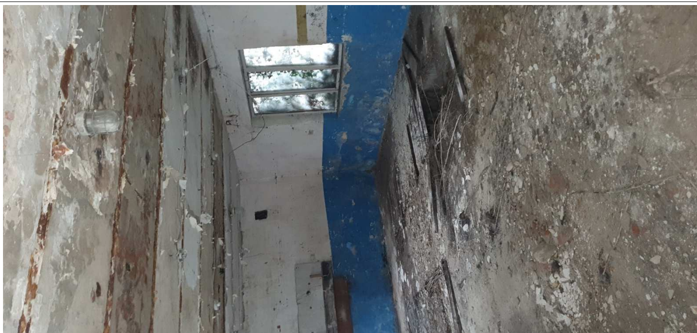
Fot. nr 2 – widok od wewnątrz budynku – poziom parteru, na fotografii widać strop odcinkowy z śladami korozji, liczne ubytki tynków, ich korozję itp.
