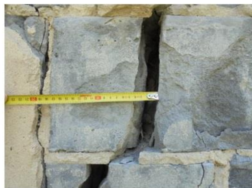
Fot.4 Pęknięcie ściany od strony północnej
