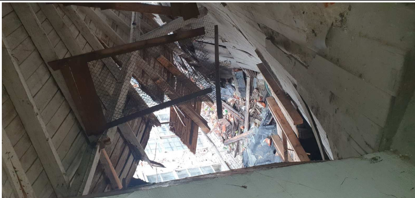
Fot. nr 4 – widok zawalonego stropu drewnianego nad pierwszym piętrzem wraz z zawaloną konstrukcją dachu
