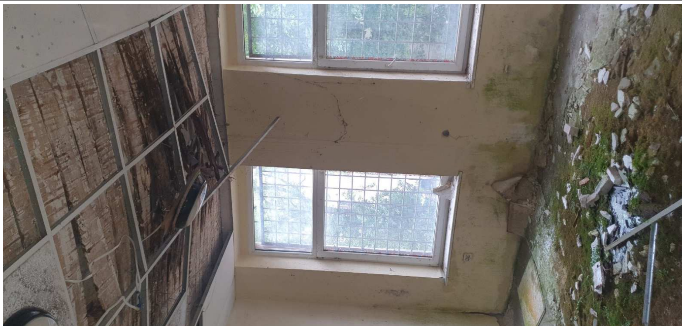
Fot. nr 3 – widok naderwanego stropu drewnianego nad pierwszym piętrem (pom. od strony Radwańska 60)
