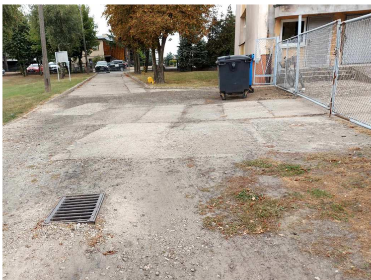
zdj. nr 4 Istniejąca droga dojazdowa z płyta betonowych wraz z widocznymi elementami kanalizacji deszczowej
