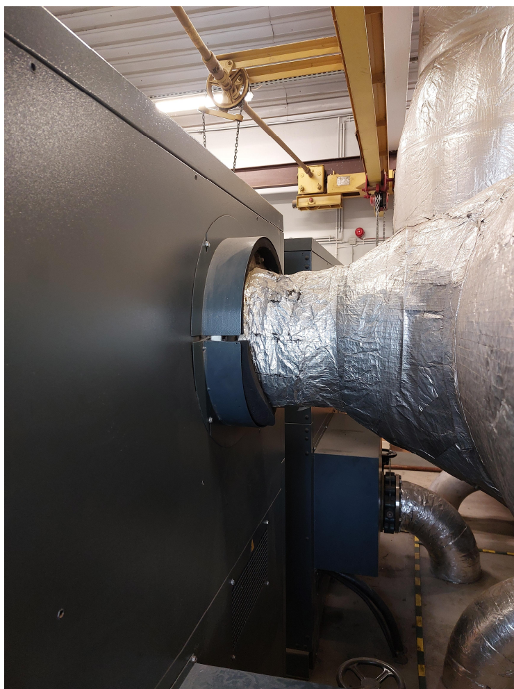
Zdj. 3 – Połączenie dmuchaw do czerpni powietrza
