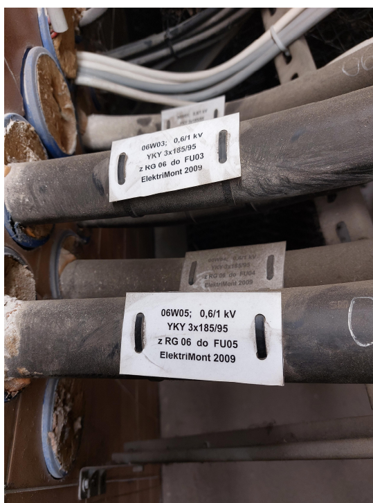
Zdj. 5 – Przekrój kabli zasilających istniejące dmuchawy
