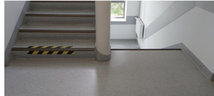
Klatka schodowa w urzędzie:
