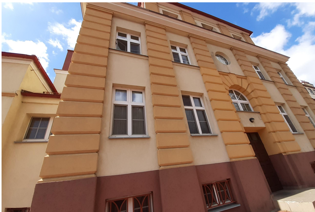
Fot. 18. Tynki cienkowarstwowe- stan ogólny dobry, lekko zanieczyszczone
