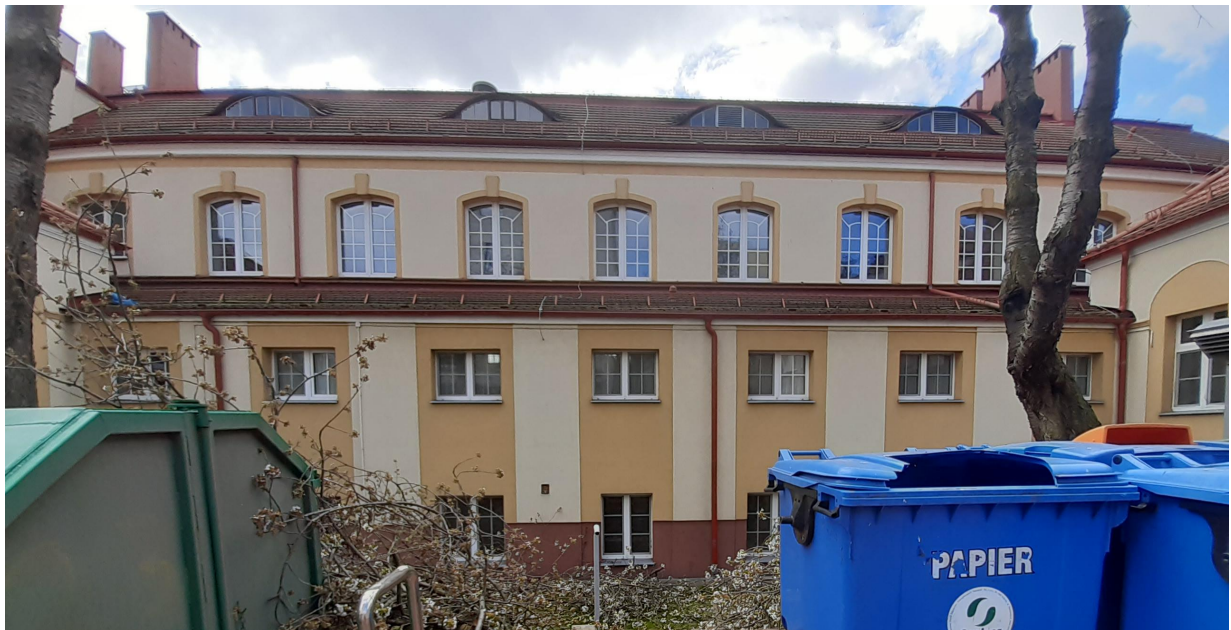
Elewacja północna - zaplecze kuchenne
