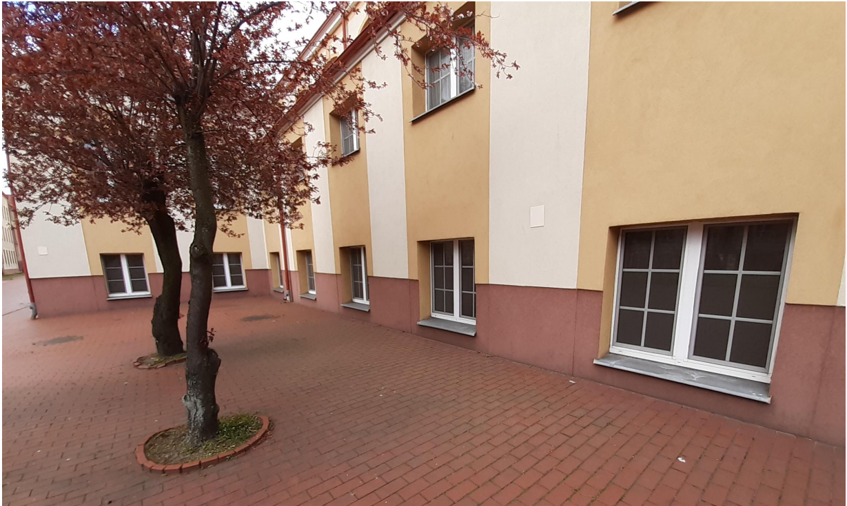
Fot. 11. Tynki cienkowarstwowe - stan ogólny dobry, lekko zanieczyszczone.
