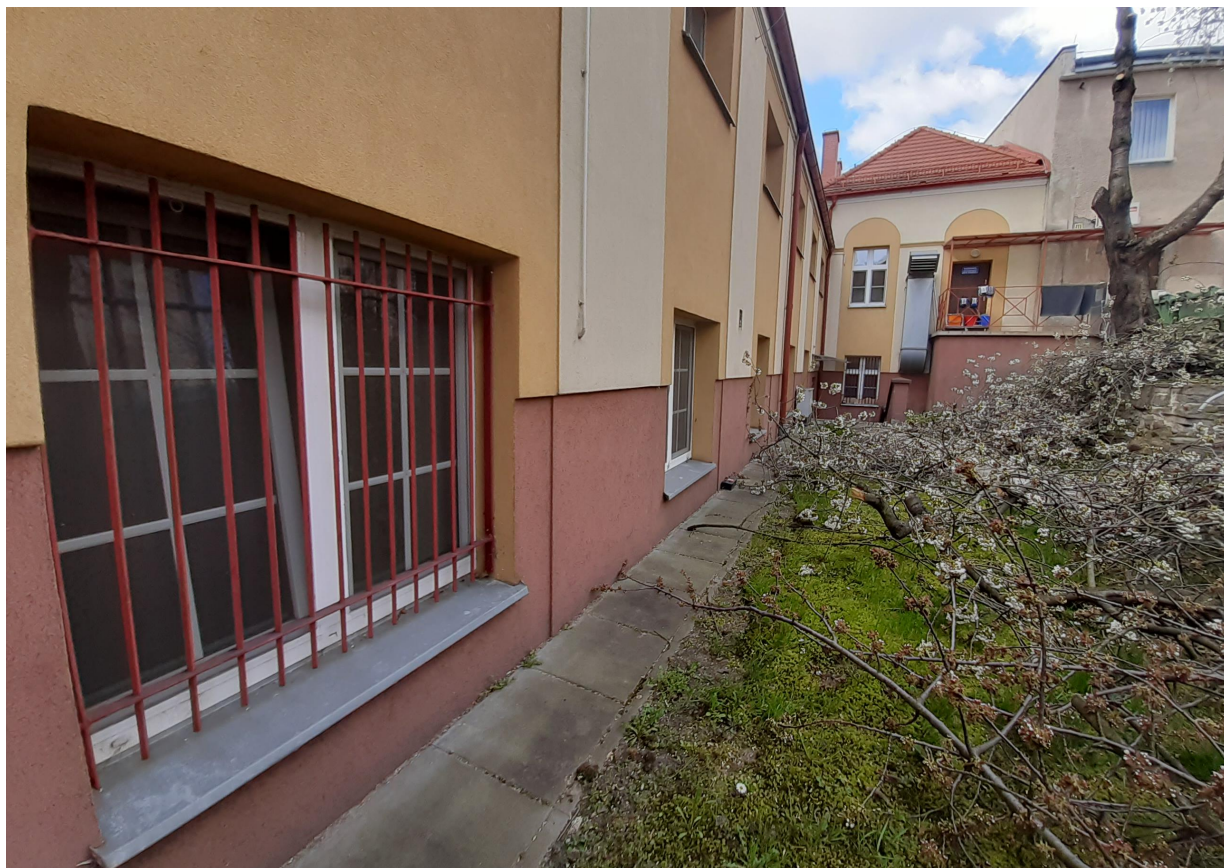
Fot. 22. Tynki cienkowsarstwowe- stan ogólny dobry, lekko zanieczyszczone.
