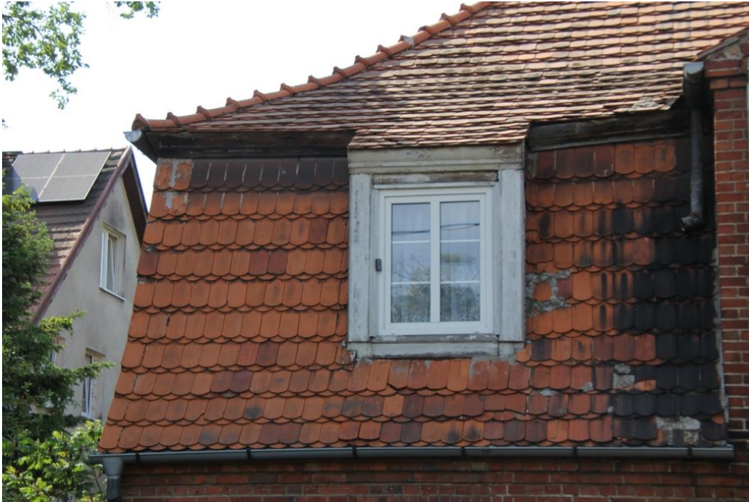
Fot. 9. Elewacja frontowa, wschodnia. Południowa część mansardy z zachowaną obudową facjarki.
