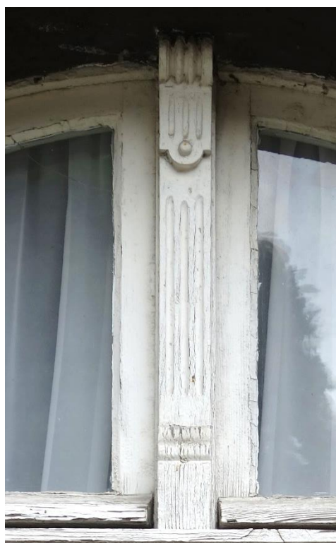
Fot. 24 a,b. Elewacja tylna, od podwórza, zachodnia. Detale okna klatki schodowej na parterze.
