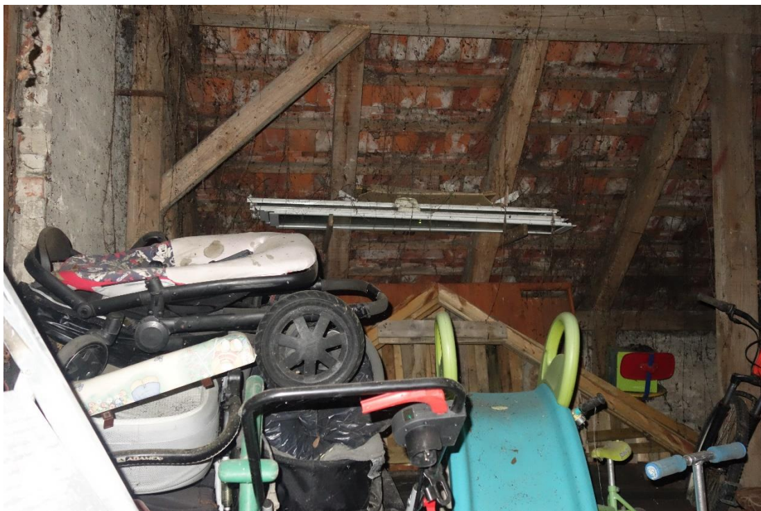
Fot. 104. Poddasze, widok połaci dachowej
