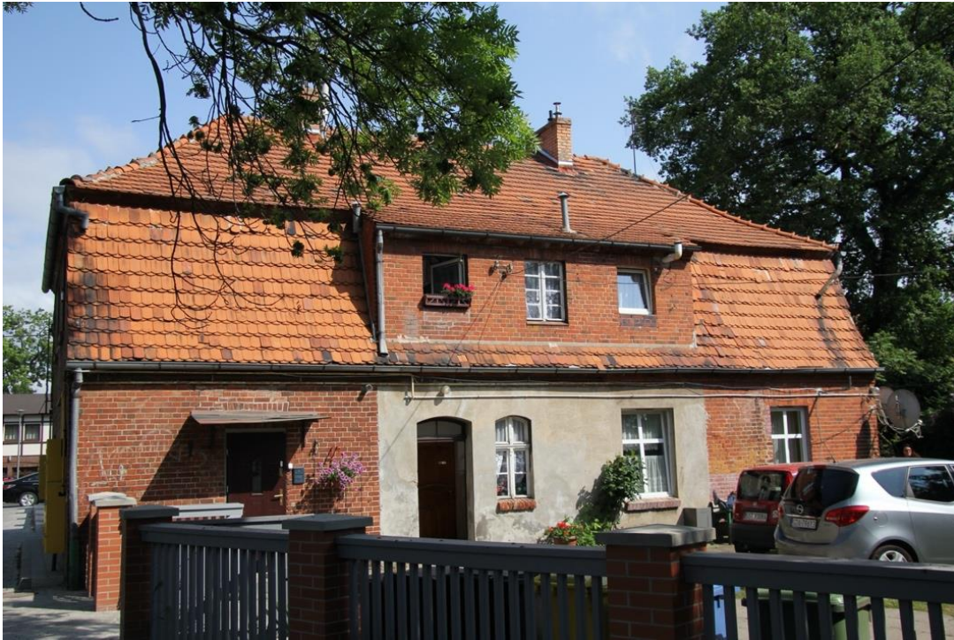
Fot. 21. Elewacja tylna, od podwórza, zachodnia. Widok ogólny. Część środkowa przyziemia wtórnie otynkowana. Wejście po lewej wtórnie, powstałe przez rozkucie otworu okiennego.
