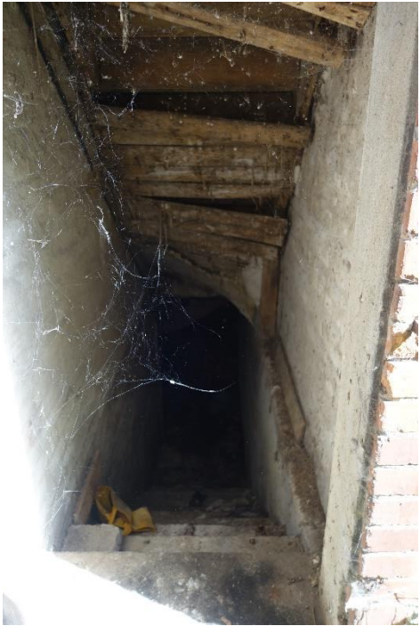
Fot. 97. Zejście do piwnicy
