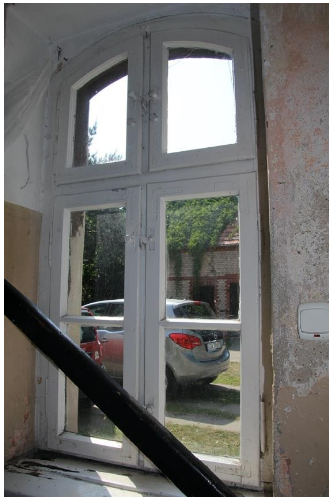
Fot. 761. Okno klatki schodowej na parterze od wnętrza.
