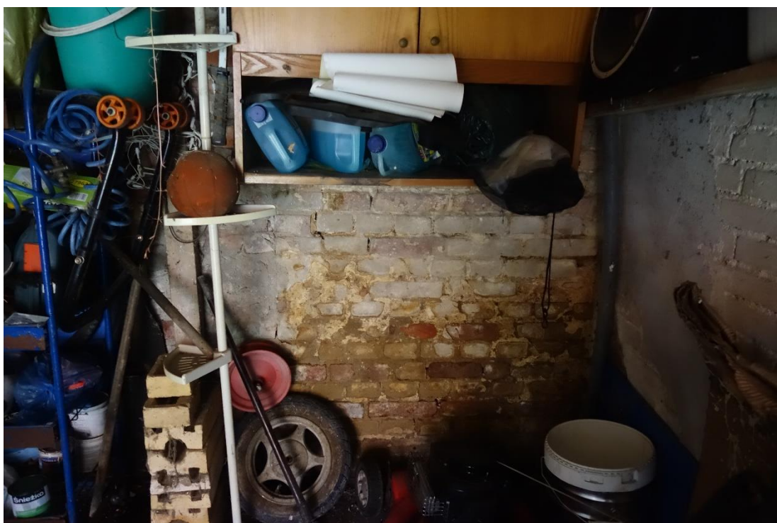
Fot. 101. Ściana dzieląca trakt środkowy
