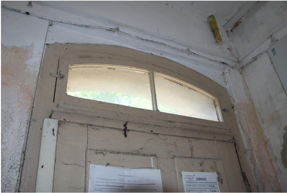
Fot. 80. Nadświetle drzwi wejściowych do budynku od strony wnętrza.
