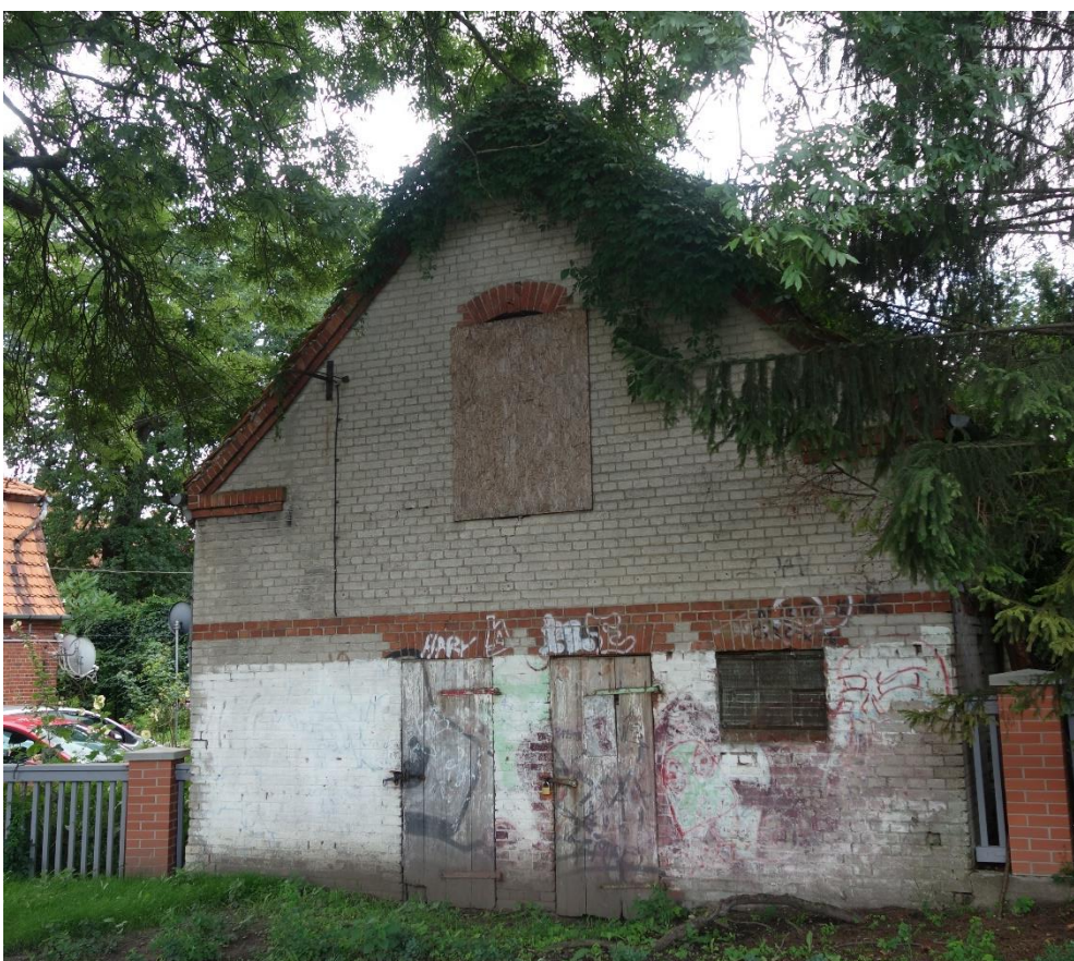
Fot. 94. Elewacja północna
