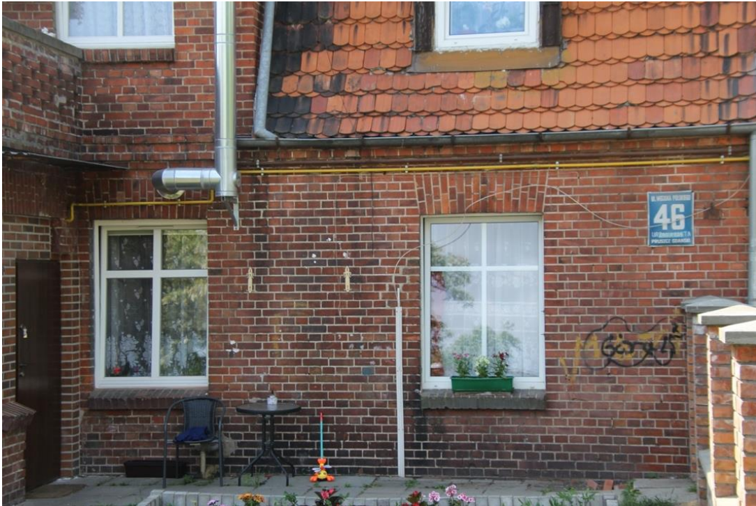
Fot. 13. Elewacja frontowa, wschodnia. Przyziemie, północna strona.
