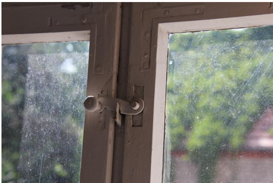
Fot. 78. Okno klatki schodowej na I piętrze. Zakrętka.
