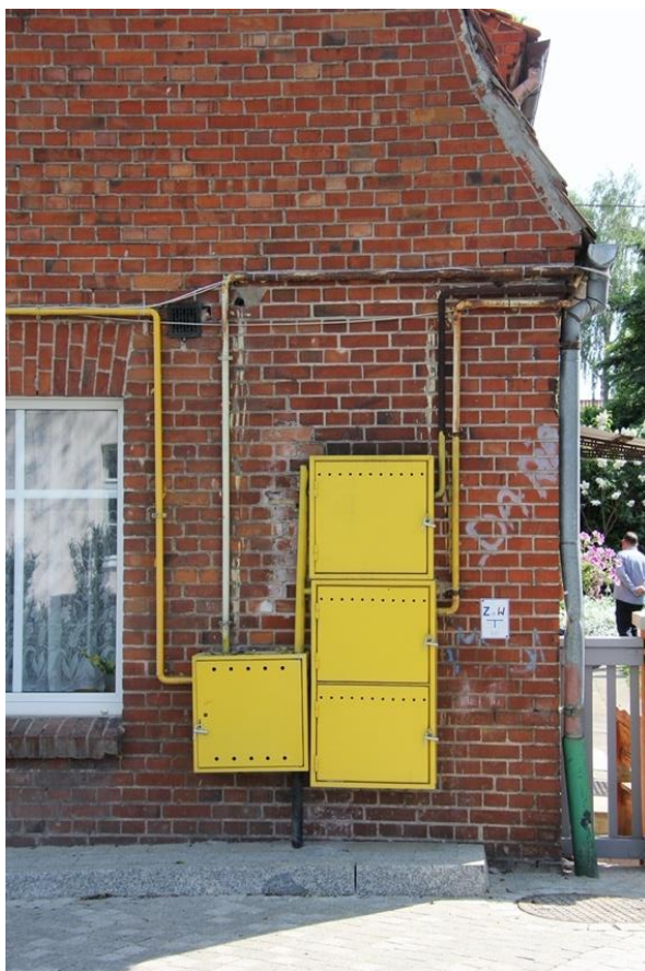
Fot. 55. Elewacja północna. Fragment przyziemia.
