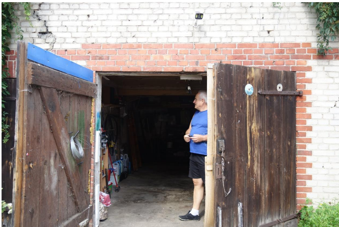
Fot. 86. Wiórne wrota w elewacji frontowej
