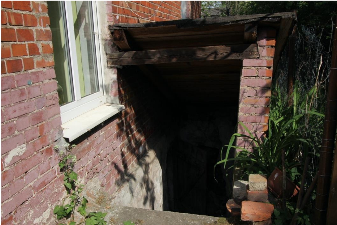
Fot. 62. Elewacja boczna, południowa. Przyziemie, wejście do piwnicy.
