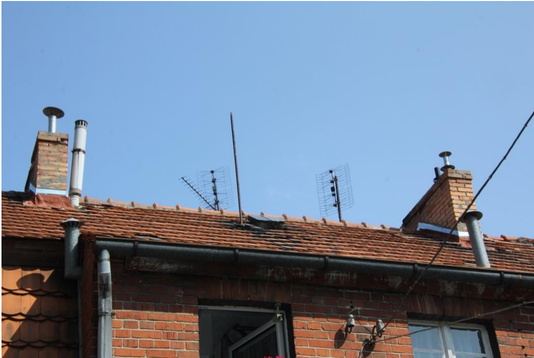
Fot. 41. Elewacja tylna, od podwórza, zachodnia. Fragment dachu i okapu dachowego.
