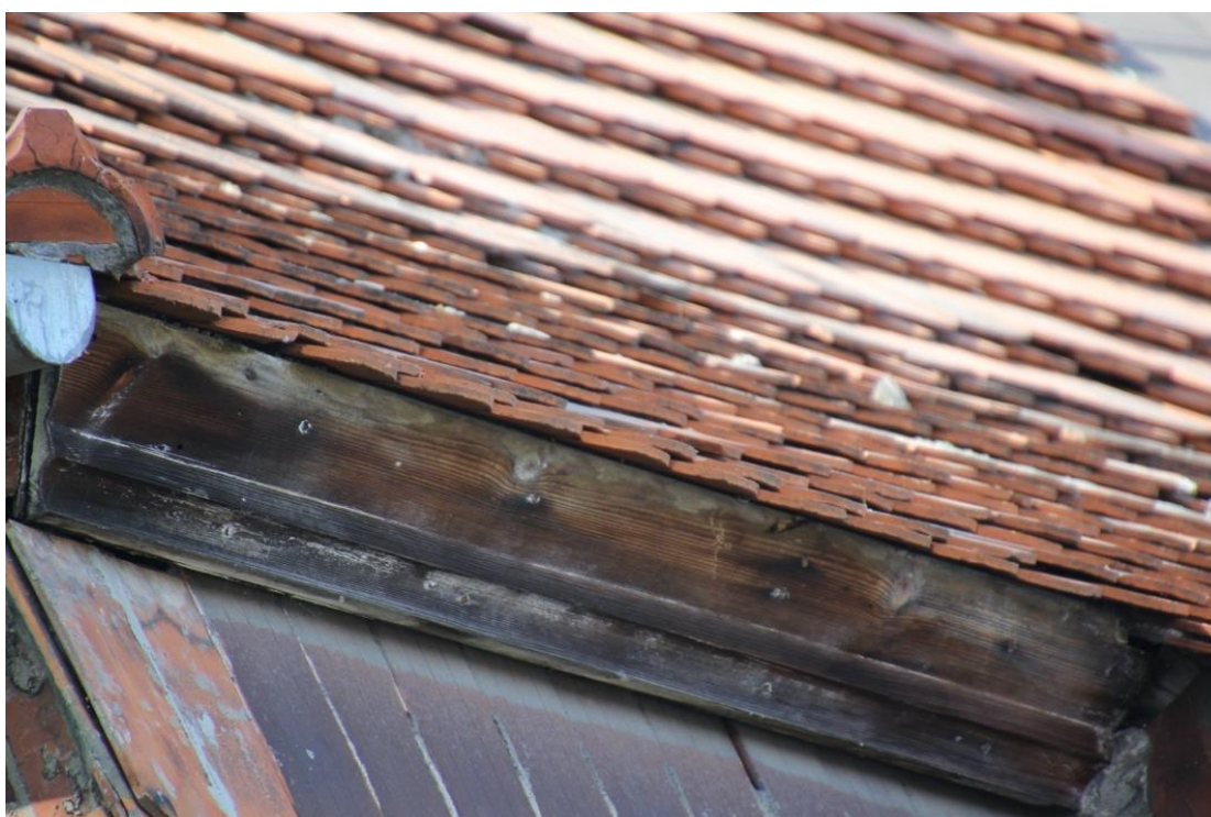
Fot. 16. Elewacja frontowa, wschodnia. Wtórny fragment maskownicy załamania połaci..
