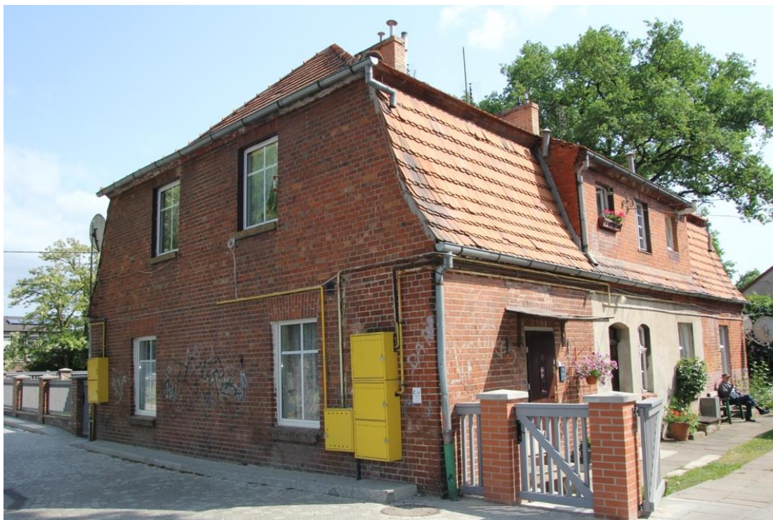
Fot. 47. Elewacja boczna, północna i tylna od podwórza. Widok ogólny.
