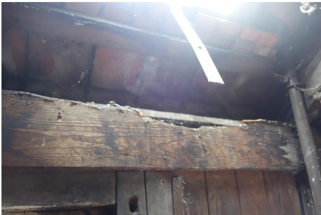
Fot. 68. Fragment więźby dachowej
