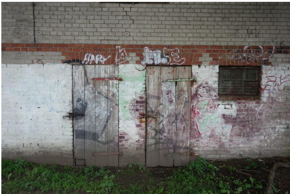
Fot. 95. Przyziemie elewacji północnej
