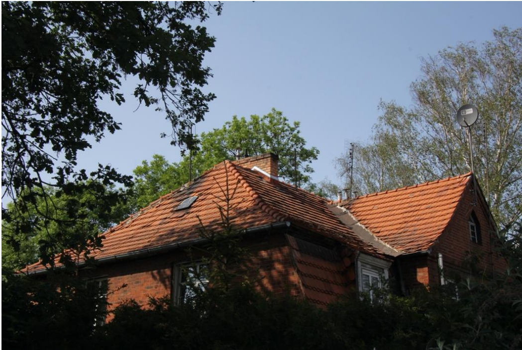
Fot. 17. Elewacja frontowa, wschodnia i południowa. Dach.
