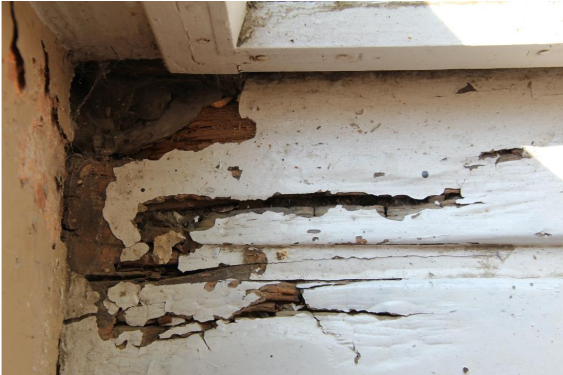
Fot. 82. Okno klatki schodowej na parterze - parapet.
