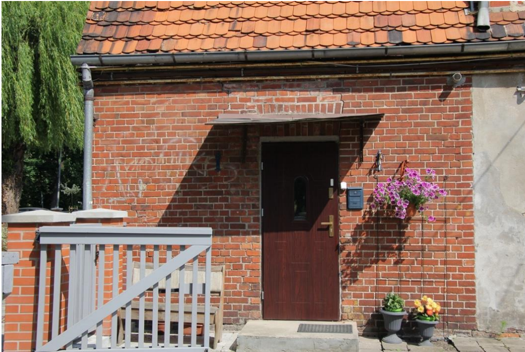
Fot. 29. Elewacja tylna, od podwórza, zachodnia. Wtórnie wybite wejście..
