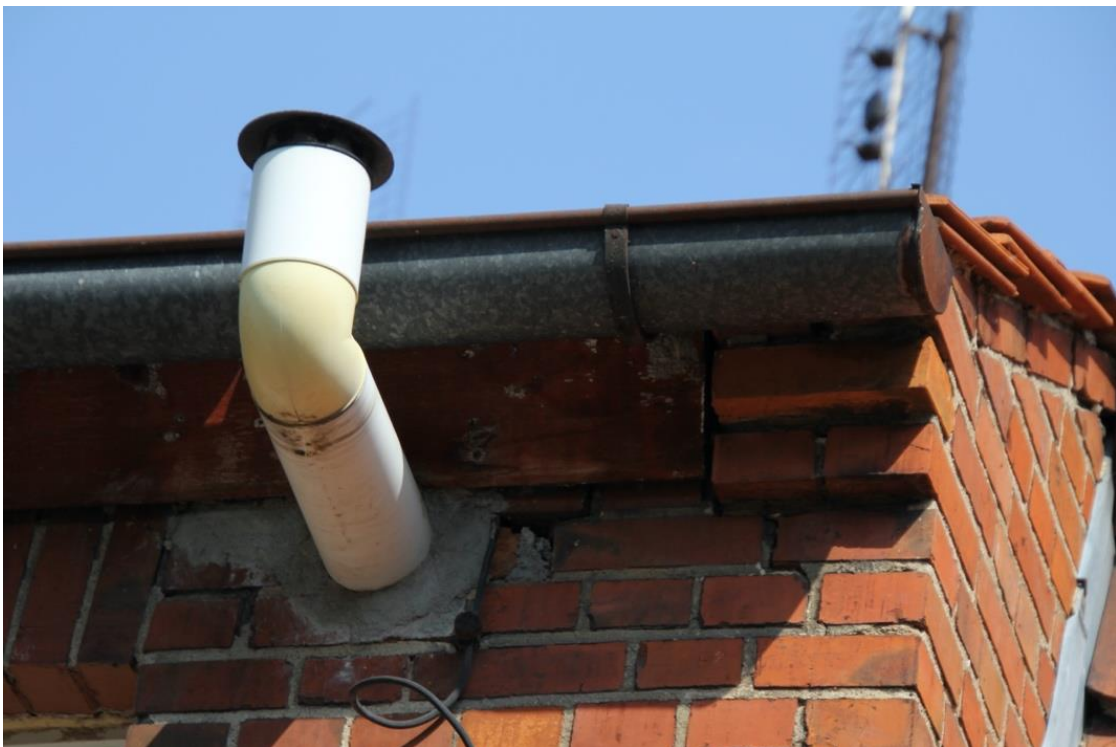
Fot. 46. Elewacja tylna, od podwórza, zachodnia, facjata, zwieńczenie.
