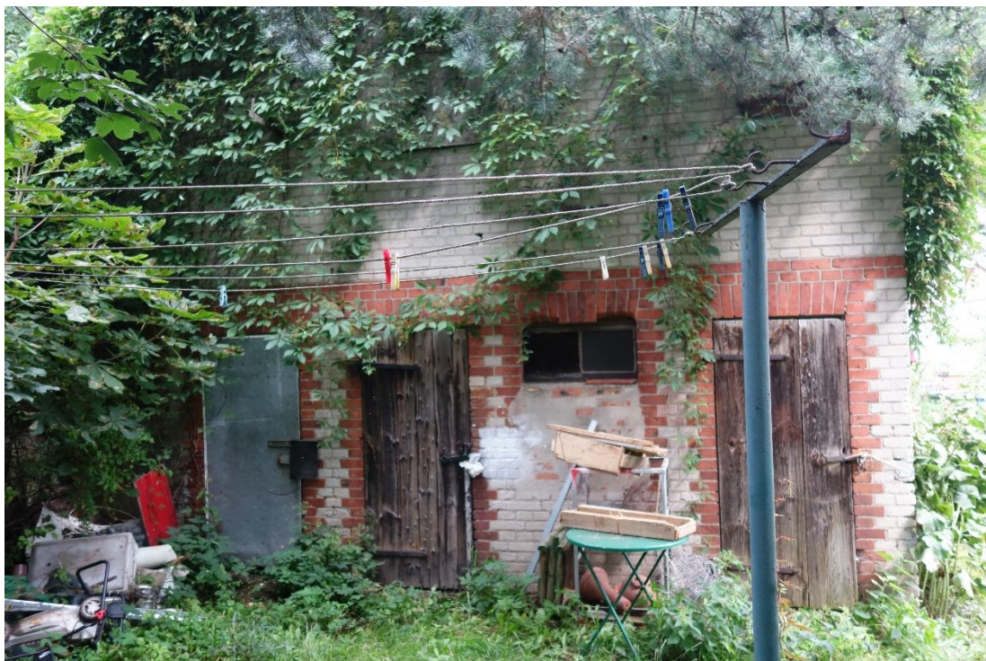
Fot. 91. Elewacja południowa
