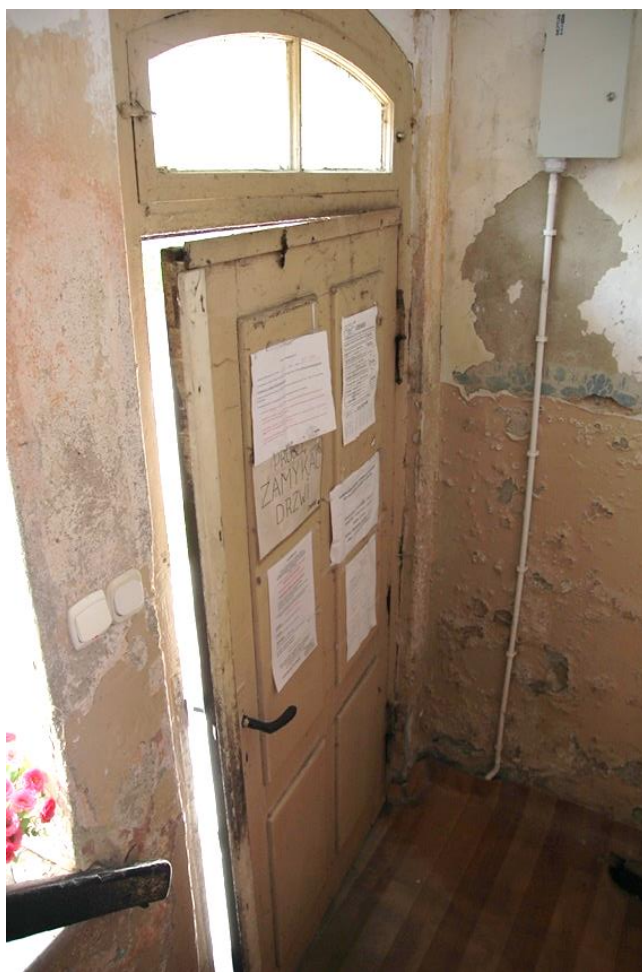
Fot. 79. Drzwi wejściowe do budynku od strony wnętrza.
