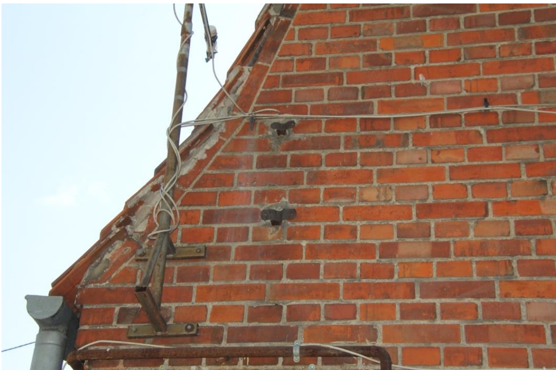
Fot. 54. Elewacja boczna, północna, fragment.
