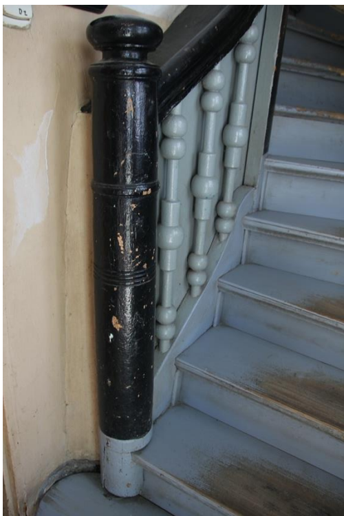
Fot. 73. Słup początkowy schodów i odcinek wtórnej balustrady.
