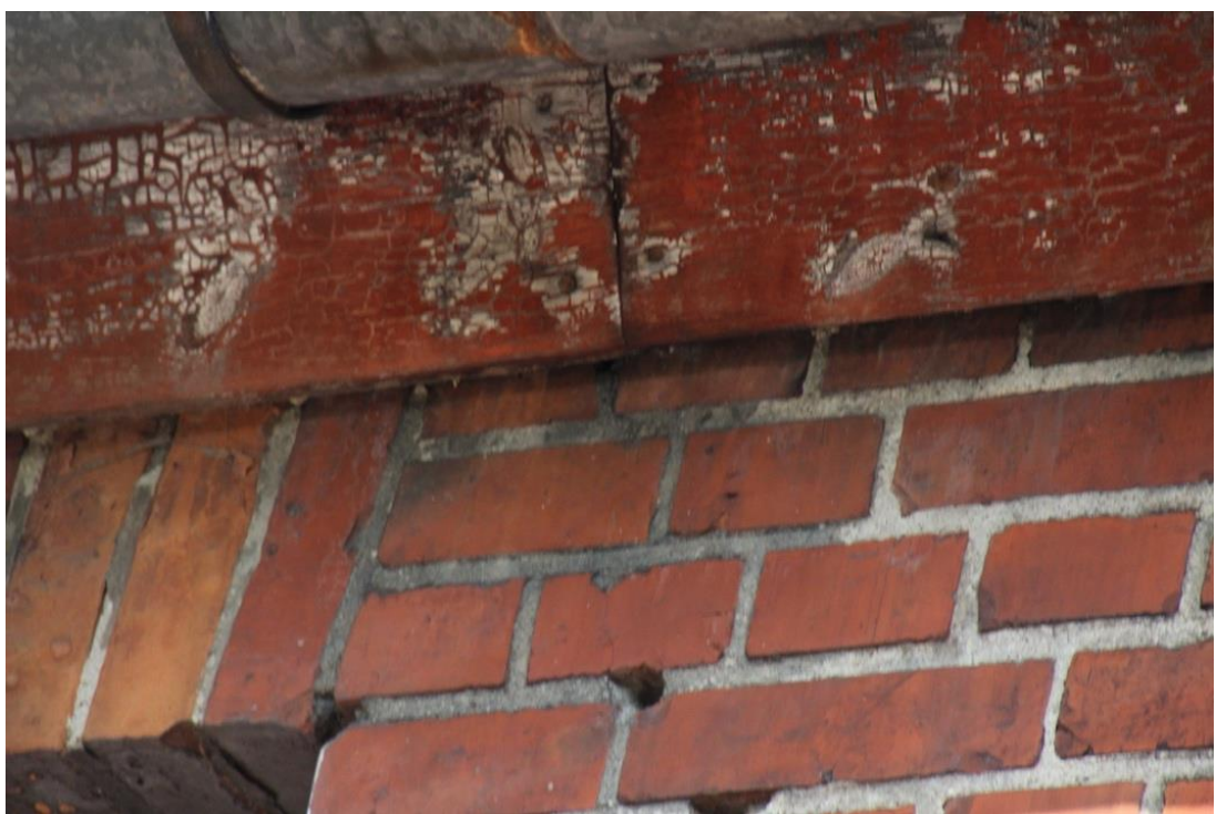
Fot. 52. Elewacja boczna, północna. Fragment maskownicy.
