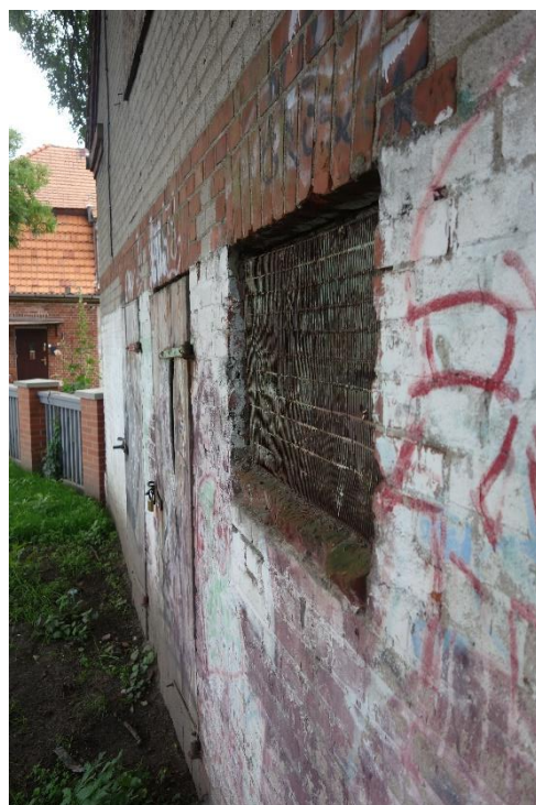
Fot. 88 Fragment elewacji północnej
