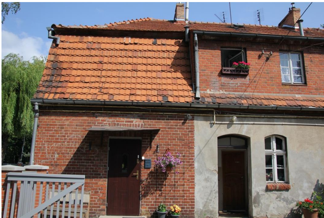
Fot. 27. Elewacja tylna, od podwórza, zachodnia, strona północna.
