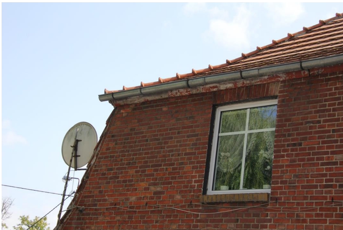
Fot. 51. Elewacja boczna, północna. Fragment I piętra.
