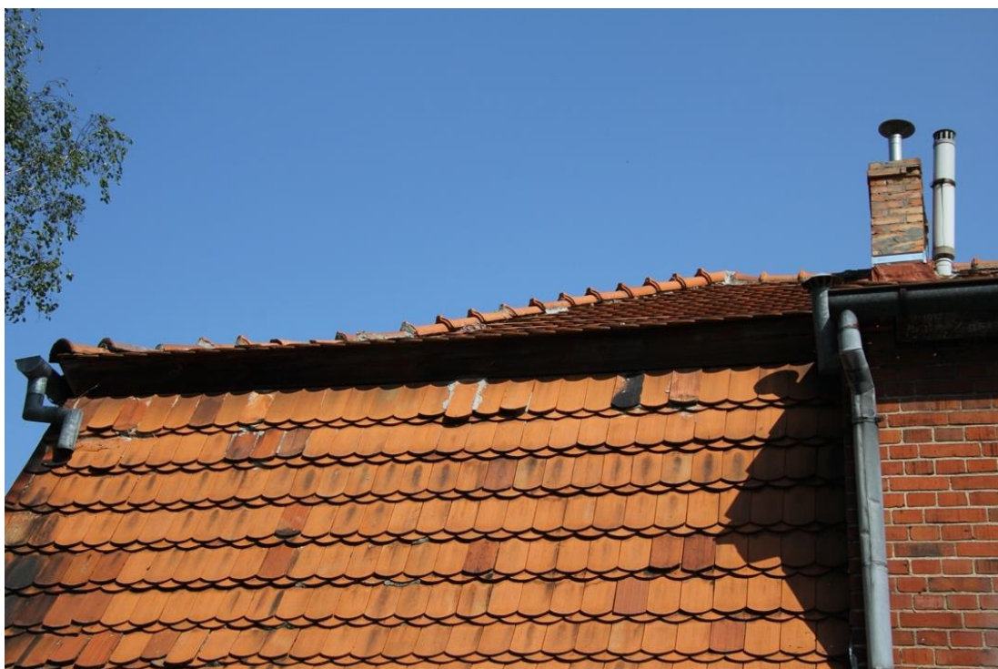
Fot. 28. Strona zachodnia dachu, fragment.
