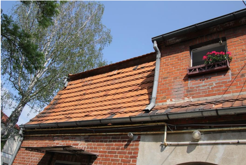
Fot. 25. Elewacja tylna, od podwórza, zachodnia. Górna kondygnacja, północna strona.
