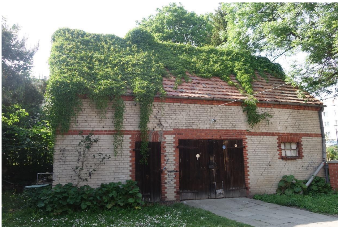
Budynek gospodarczy przy ul. Wojska Polskiego 46 od strony wschodniej, stan obecny
