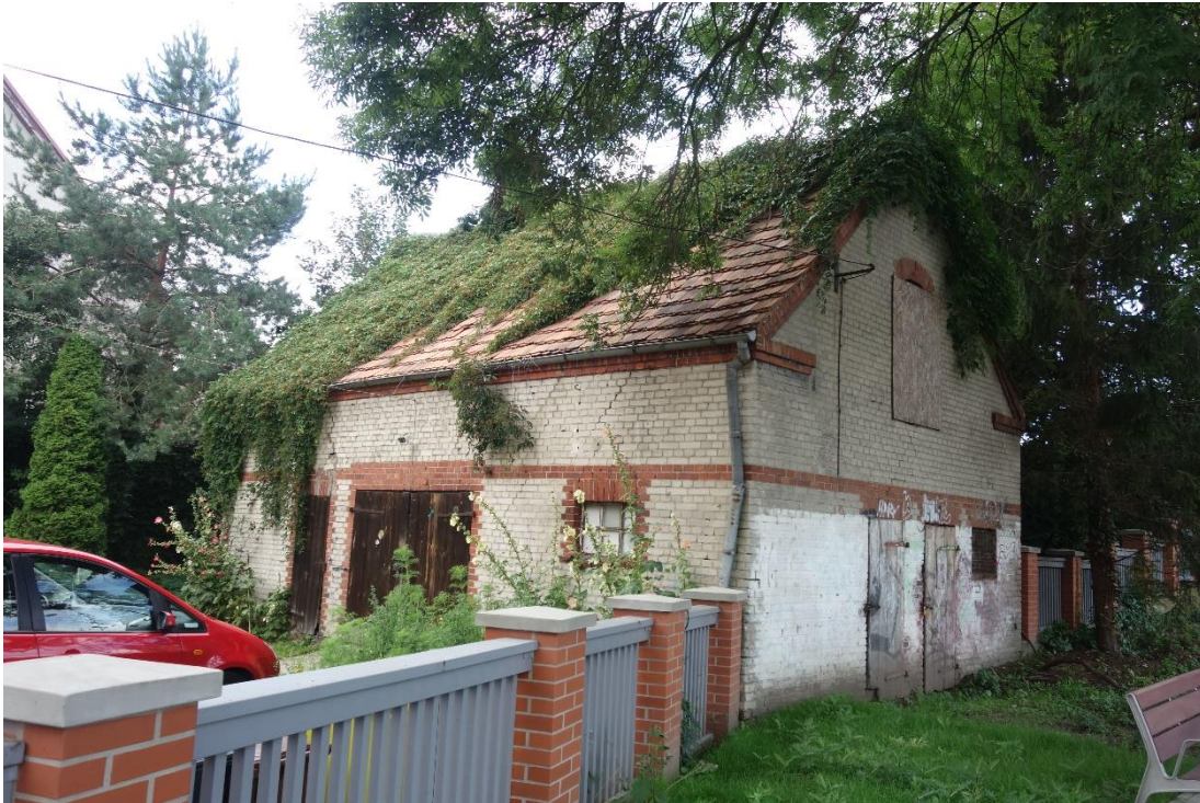
Fot. 84. Budynek gospodarczy, widok na elewację frontową i północną .
