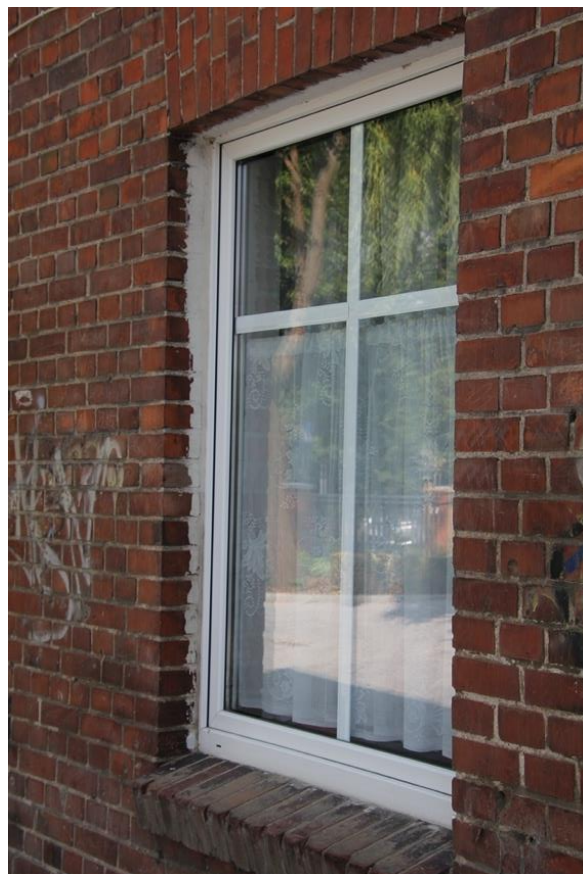
Fot. 56. Elewacja północna, fragment
