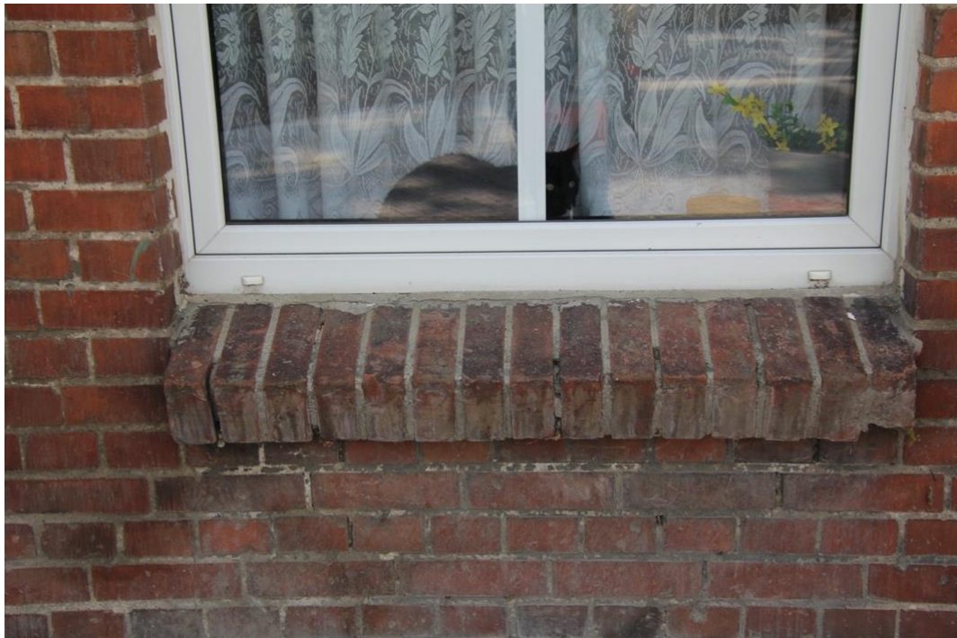
Fot. 40. Elewacja tylna, od podwórza, zachodnia. Ceglany parapet.
