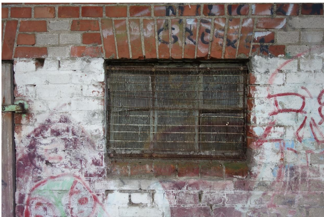
Fot. 96. Okienko elewacji północnej
