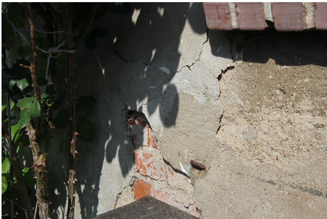
Fot. 64. Elewacja boczna, południowa. Fragment wtórnie otynkowanej ściany poniżej gruntu w zejściu do piwnicy.
