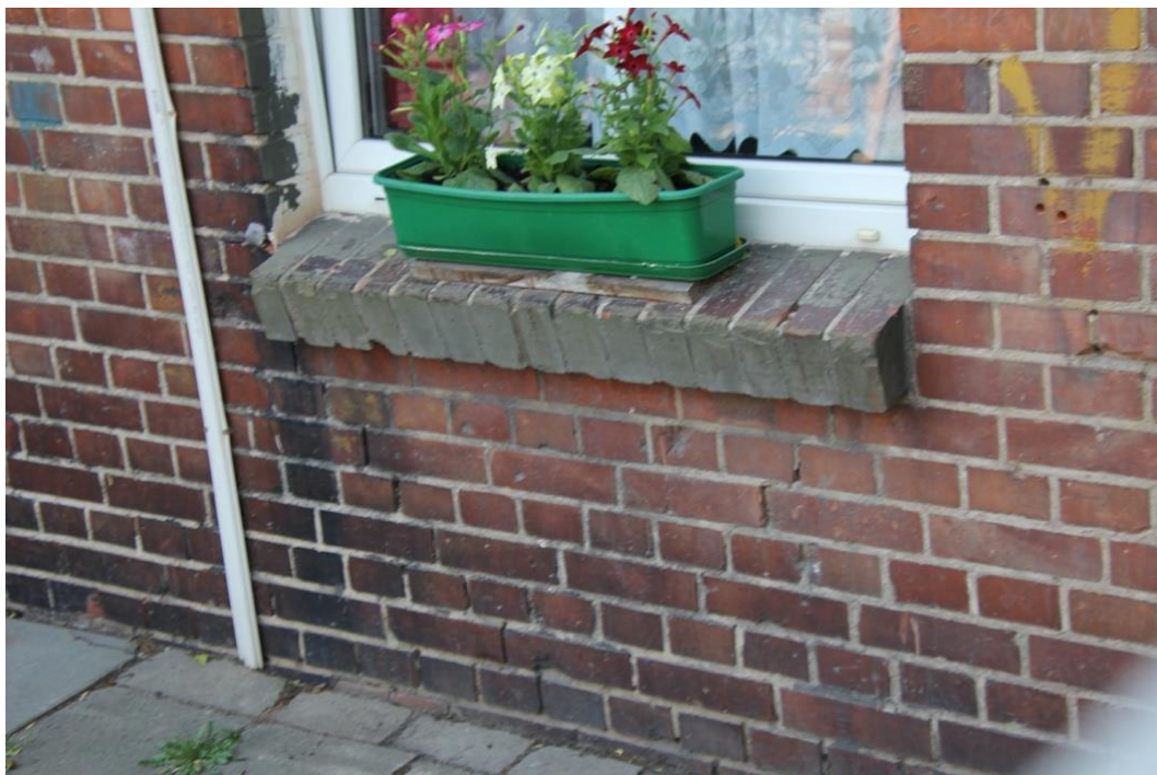
Fot. 39. Elewacja tylna, od podwórza, zachodnia. Fragment przyziemia prawej strony budynku.
