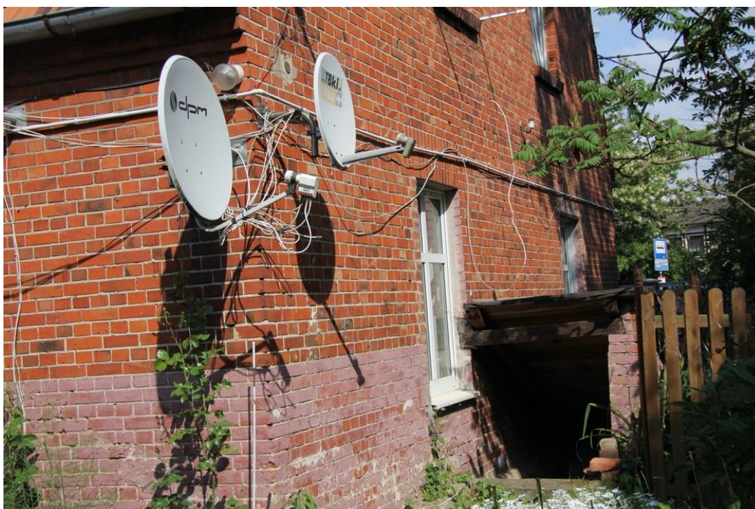
Fot. 61. Elewacja boczna, południowa. Przyziemie z pasem wtórnie pomalowanej cegły.
