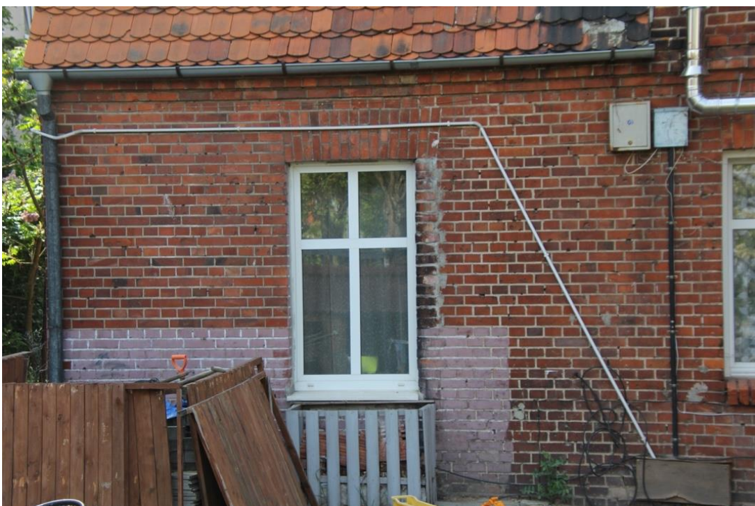
Fot. 14. Elewacja frontowa, wschodnia. Przyziemie, południowa strona.
