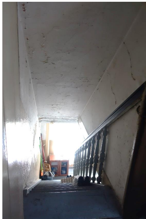
Fot. 71. Schody ze strychu na piętro.
