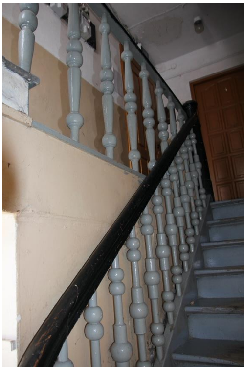
Fot. 70. Schody pomiędzy parterem a I pięciem.
