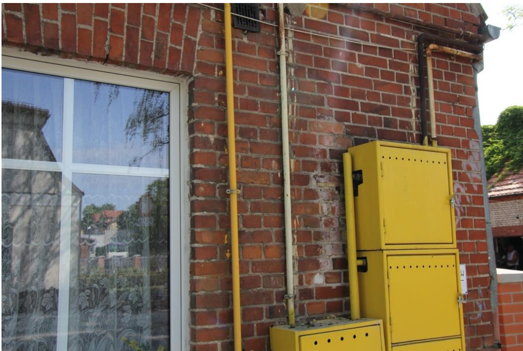
Fot. 50. Elewacja boczna, północna. Wtórne naprawy i instalacje.
