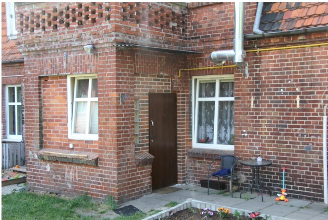
Fot. 7. Elewacja frontowa, wschodnia. Widoczne wtórne wejście w ganku.
