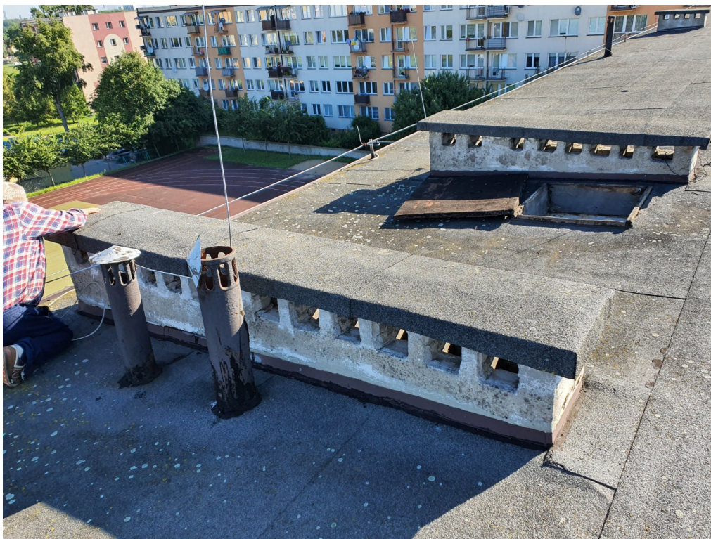
Zdj.2 . Naprawa daszków kominów kanalizacyjnych oraz wymiana wyłazu dachowego.
