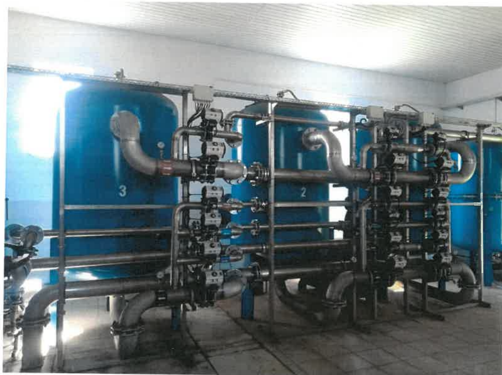
Fot. 8 Zestaw filtrów, orurowania, przepustnic do przebudowy.
