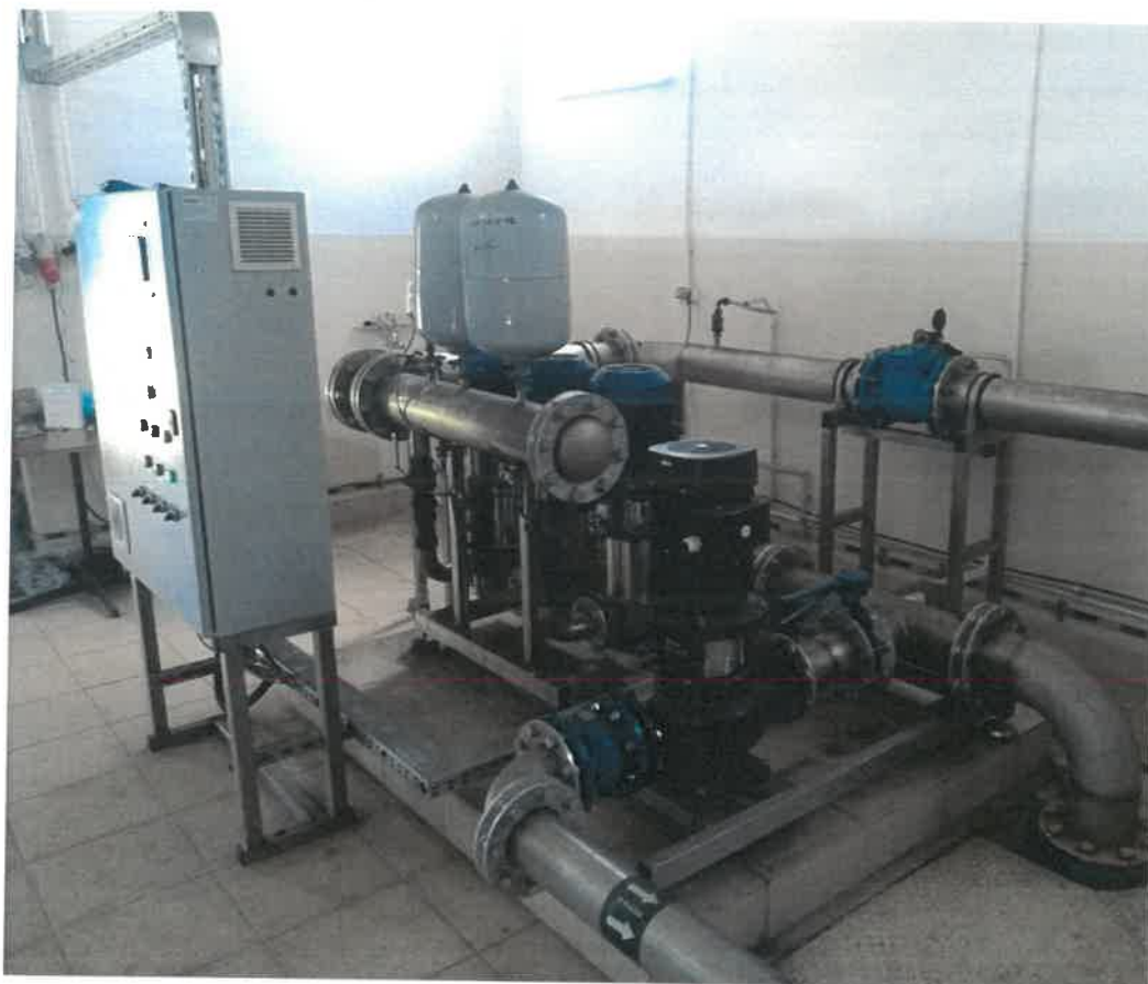
Fot. 7 Zestaw hydroforowy istniejący.
