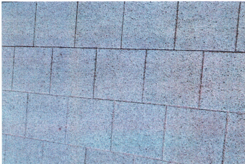
Fot. Płytki chodnikowe
