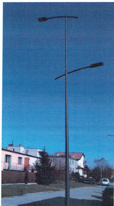
Fot. Przykładowy słup i oprawy oświetleniowe uliczne
