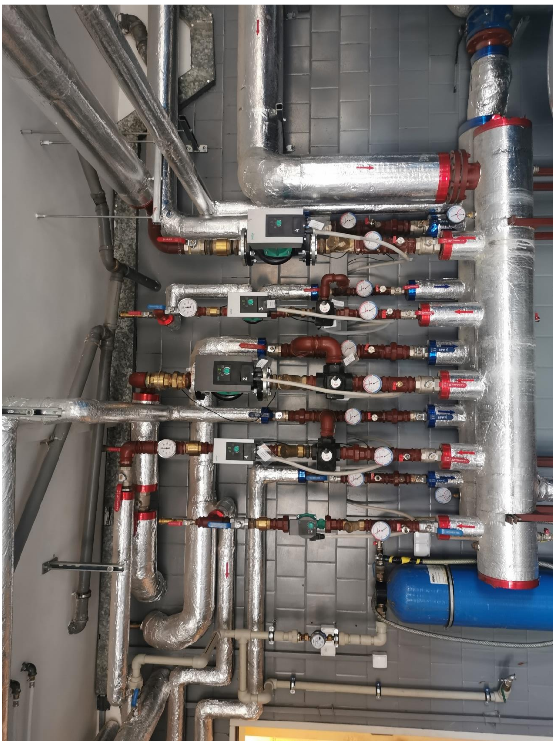
Zdjęcie 3. Widok na istniejący rozdzielacz obiegów grzewczych
