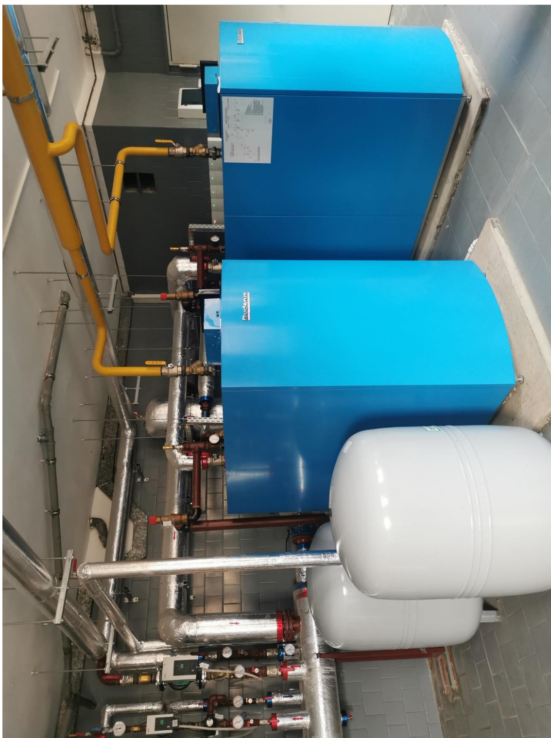
Zdjęcie 2. Widok na istniejący układ kotłowy wraz z zasileniem rozdzielacza
