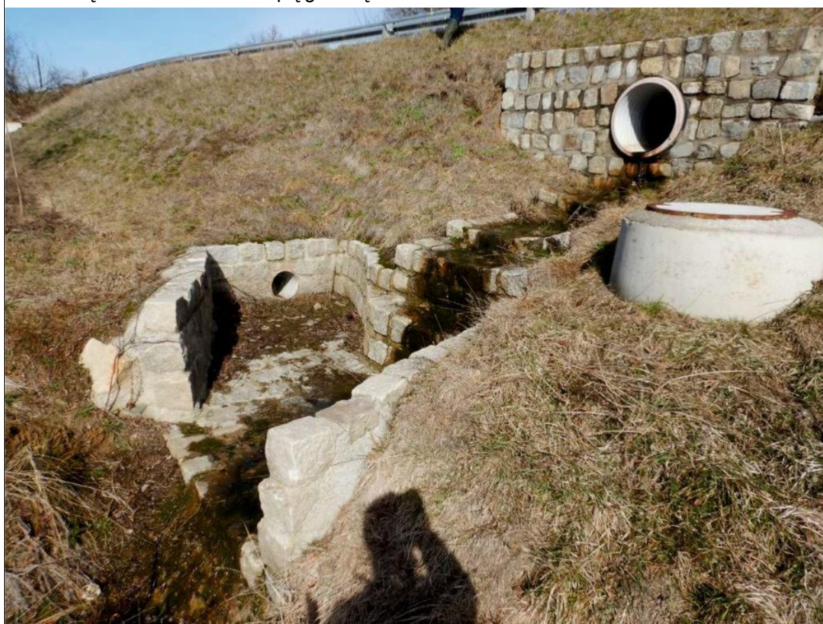
Przepusty odwadniające górną część osuwiska i zrzucające wodę w dolną część koluwium.
