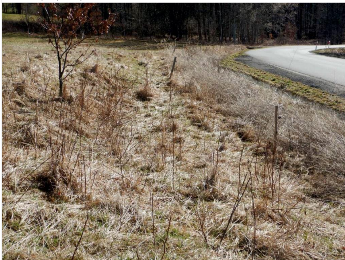
Skarpa wtórna i obniżenie terenu ponad drogą.
