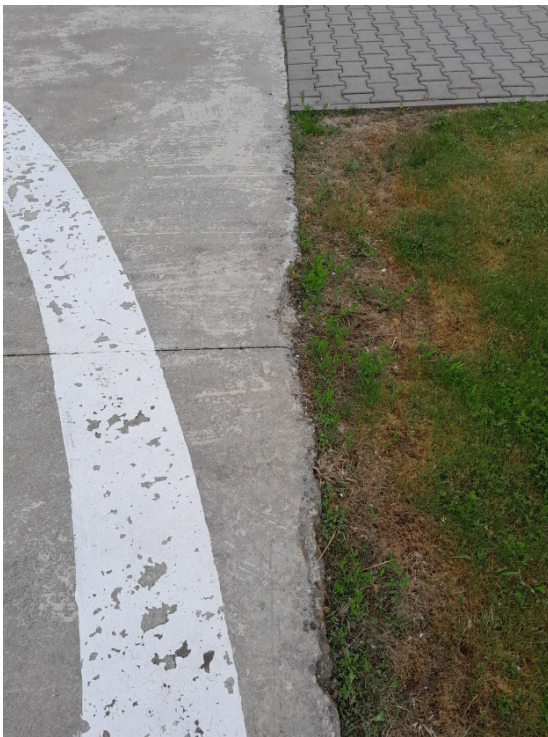
Zdj. 1. Brak wypełnienia szczelin płyty betonowej
