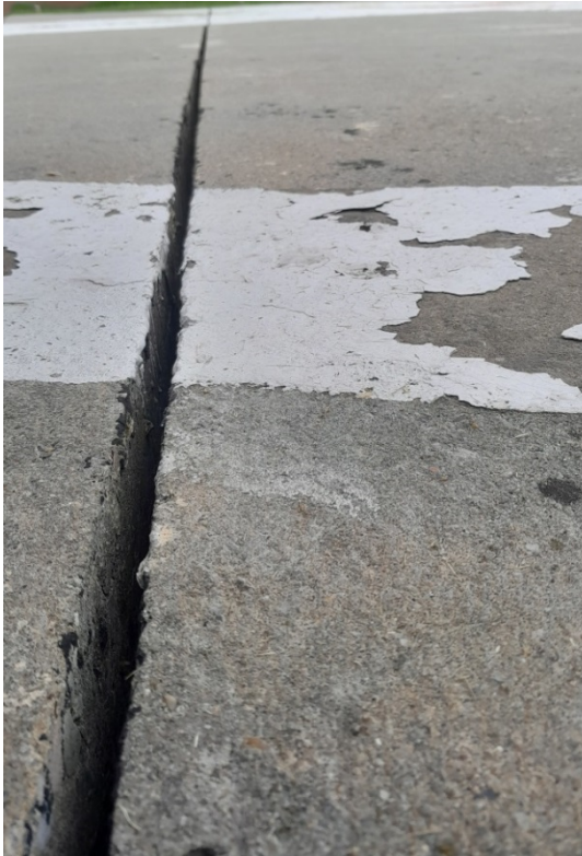
Zdj. 1. Brak wypełnienia szczelin płyty betonowej
