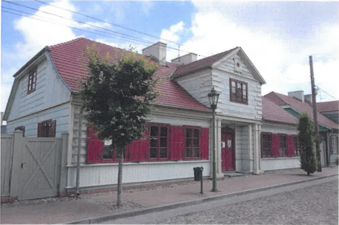
Rys 2. Budynek przy ul. Narutowicza 5
