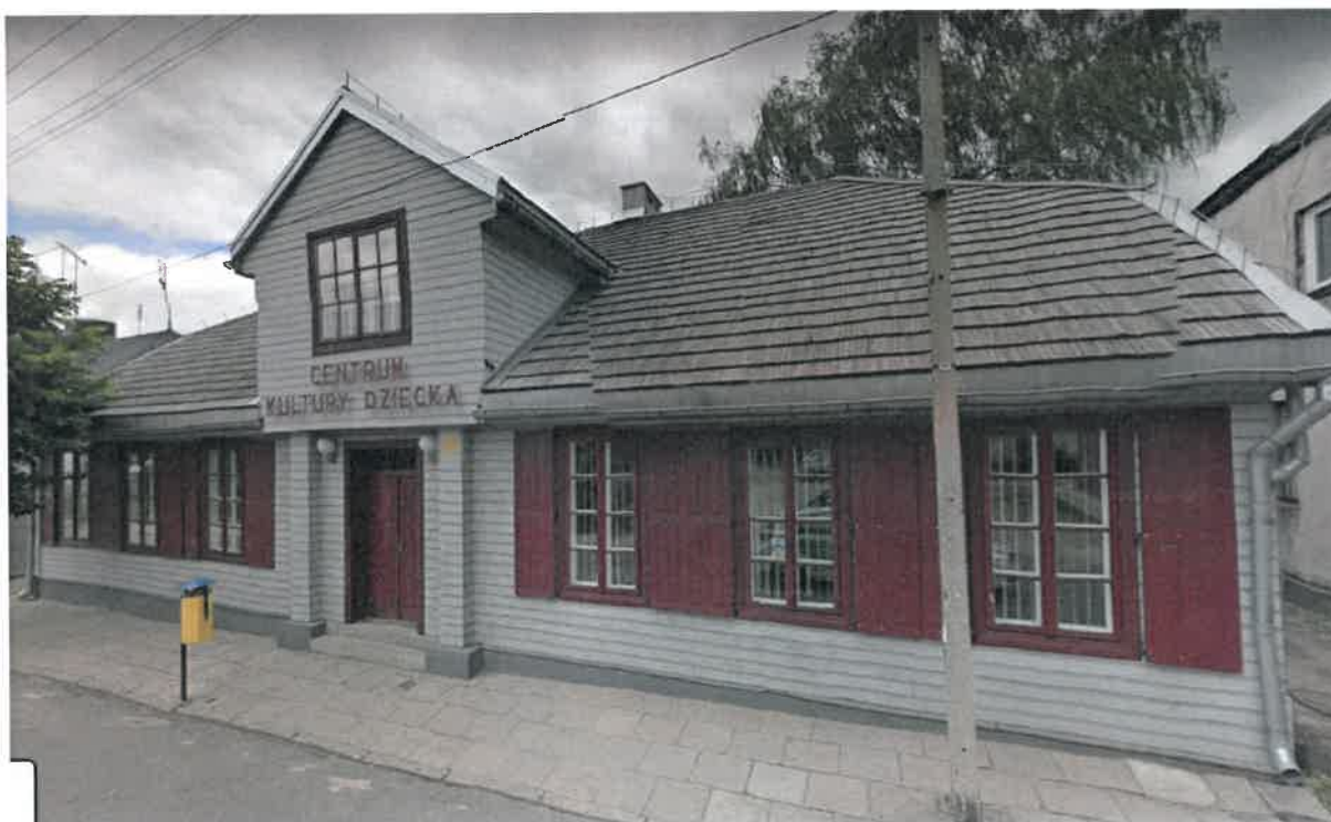
Rys 2. Budynek przy ul. Rembowskiego 17
