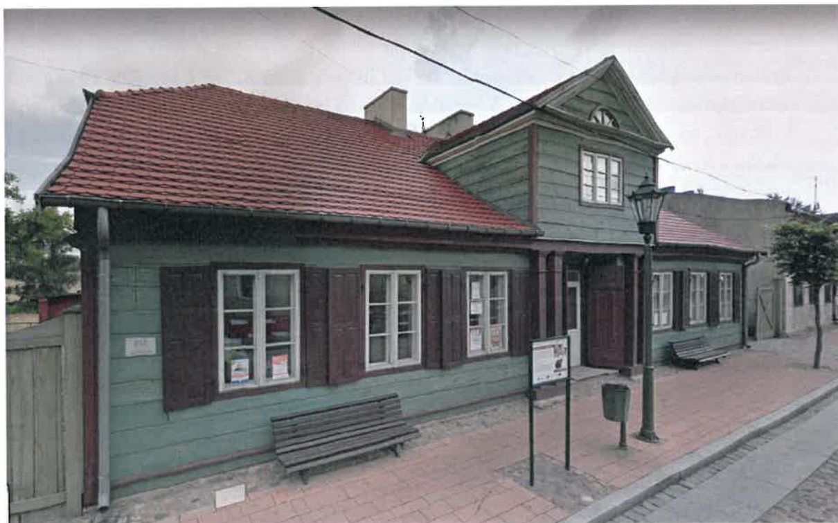
Rys. 1. Budynek przy ul. Rembowskiego 1
