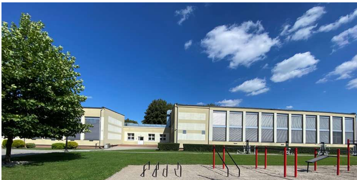
Fotografia 1. Budynek nr 24 (hala sportowa)
