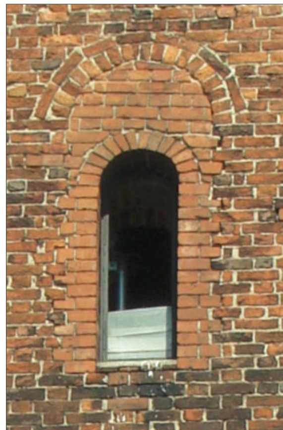
→ ■ Okno wieży. Widoczne zmiany wielkości otworu w stosunku do pierwotnych.
