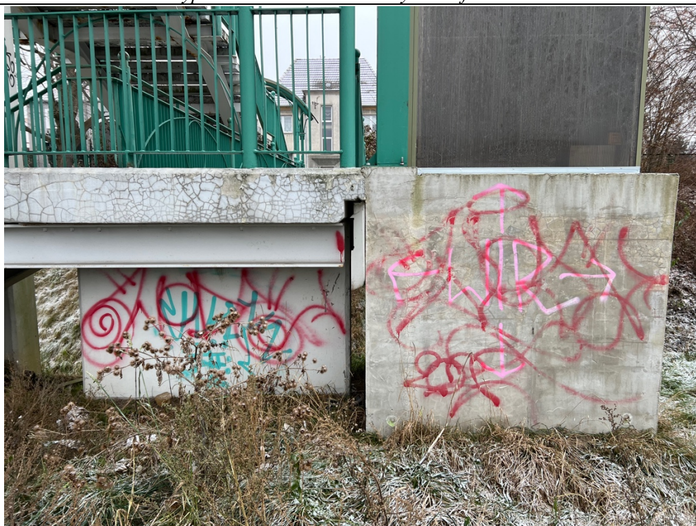
Fot. 6. Fundamenty biegów schodowych, spoczniki.
