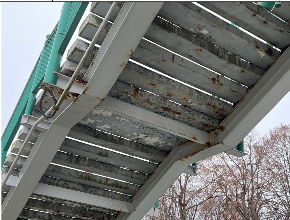
Fot. 7. Konstrukcja schodów od spodu.
