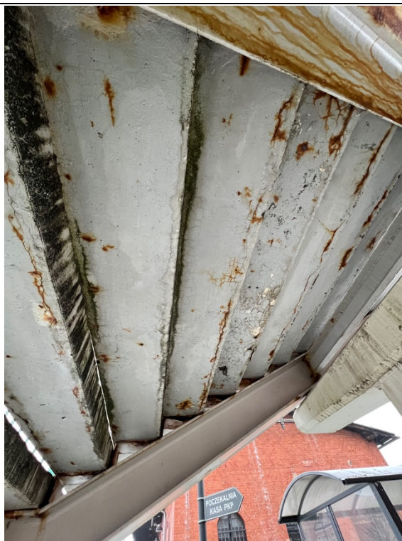
Fot. 2 Konstrukcja schodów od spodu.
