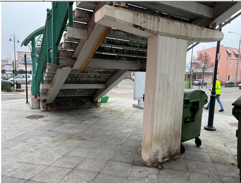
Fot. 1. Konstrukcja schodów od spodu.
