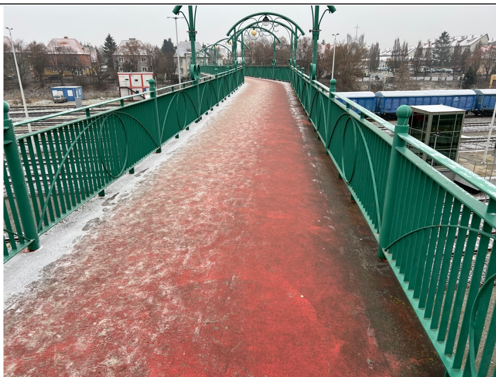
Fot. 10. Nawierzchnia na obiekcie.
