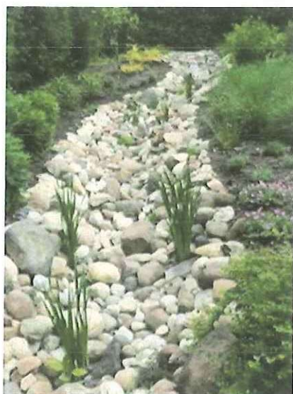
Ryc.15 i 16 Przykładowe rozwiązanie niecki retencyjnej i ogrodu deszczowego. Źródło: https://www.pinterest.de/pin/506443920601001558/
