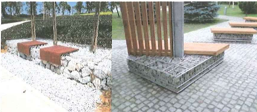
Ryc. 32 i 33 Przykładowe formy murków oporowych z koszy gabionowych
