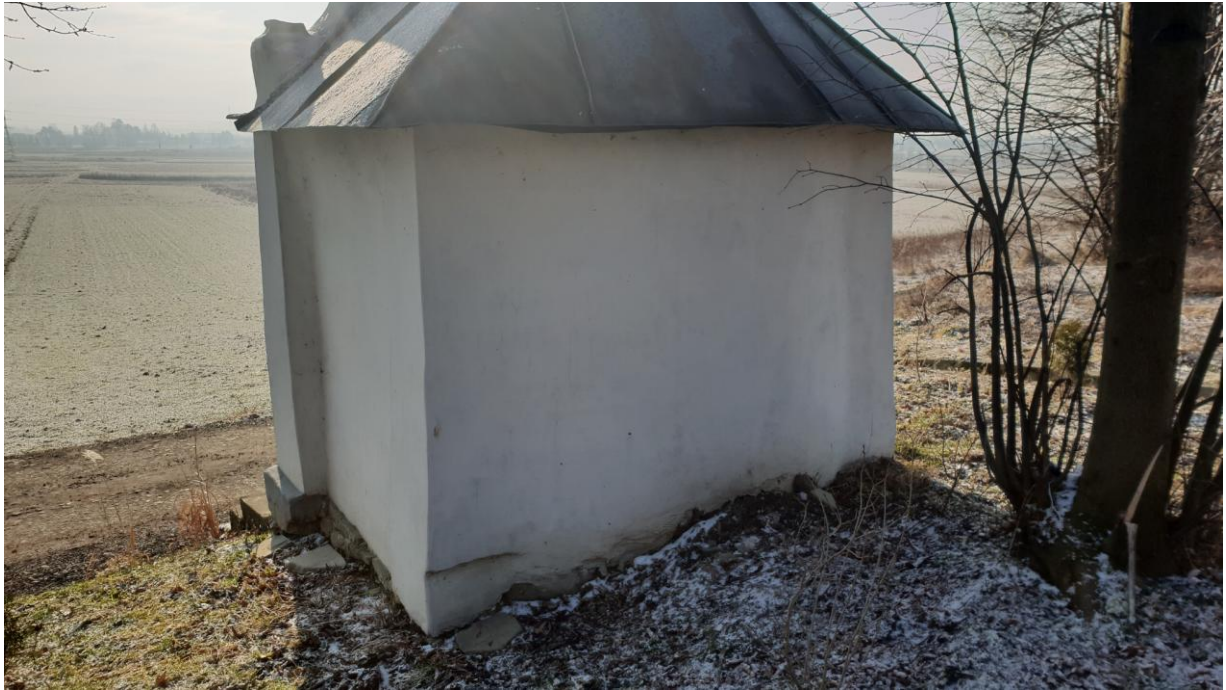
Fot.6 Kapliczka w Niskowej-ściany wschodnia i północna. Stan –luty 2021
