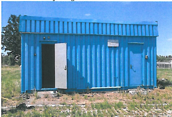
Fot. Nr1. Widok elewacji południowej
