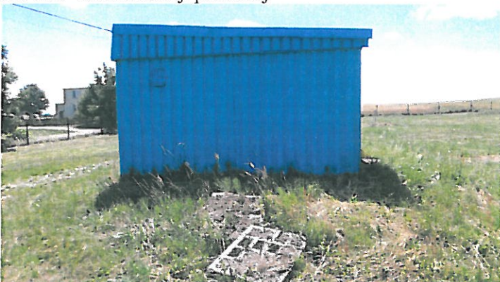
Fot. Nr1. Widok elewacji wschodniej
