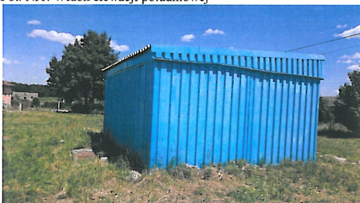
Fot. Nr1. Widok elewacji zachodniej
