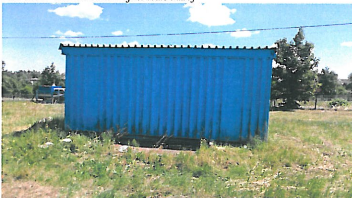
Fot. Nr1. Widok elewacji północnej
