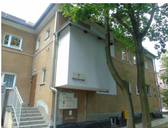
Fot. 11 Dobudowany wykusz klatki schodowej
