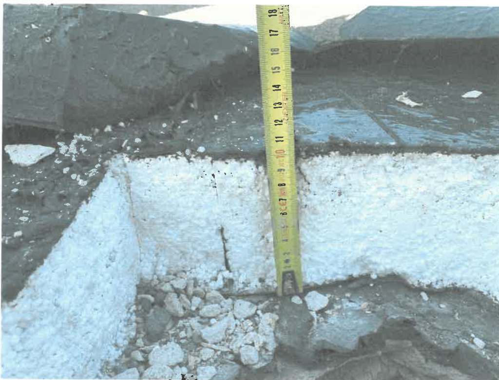
Zdj.3 – Przekrój dachu głównego – szedowego
