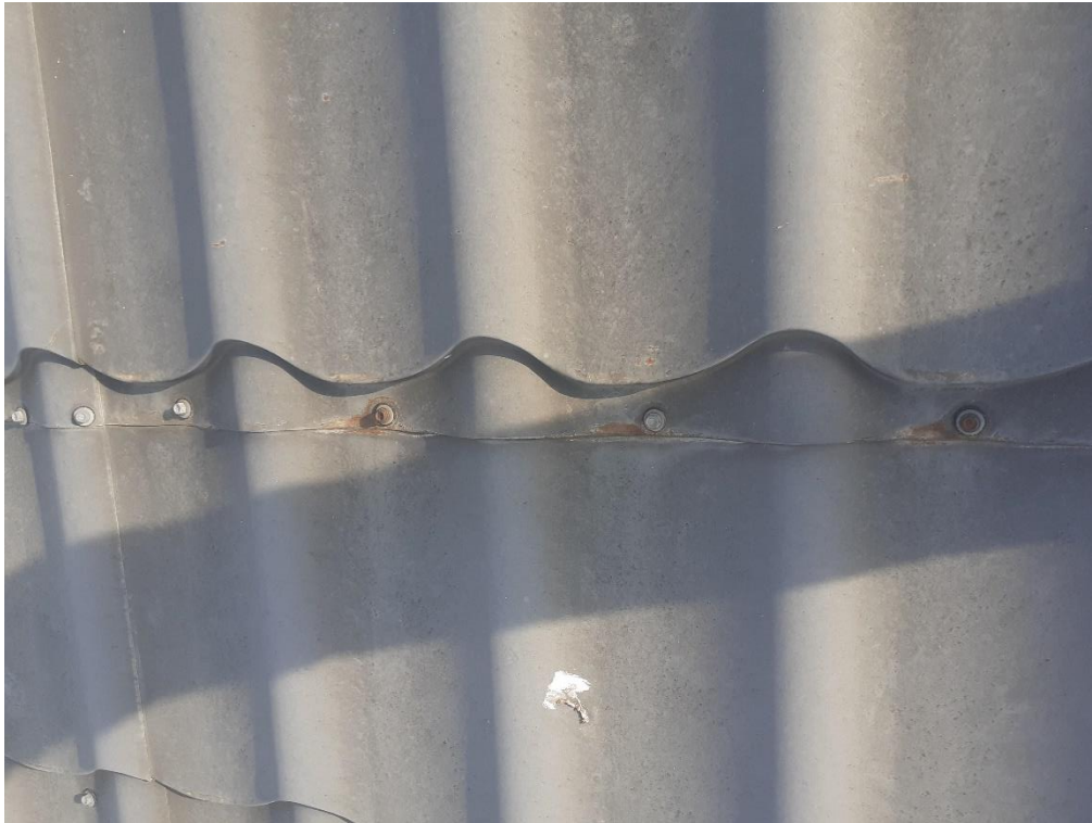
Korozja pokrycia dachowego
