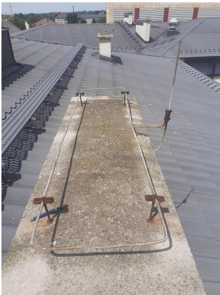
Czyszczenie i malowanie „czapki” kominowej farbą do betonu, malowanie wsporników instalacji odgromowej, wymiana skorodowanych złączek instalacji odgromowej
