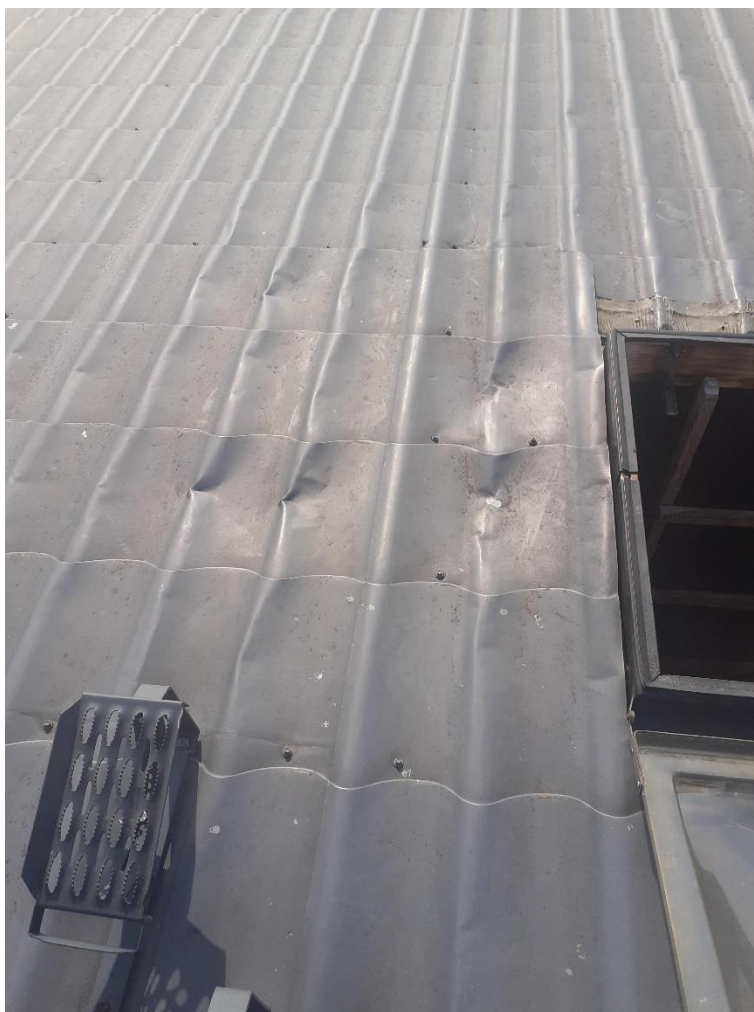
Wymiana blachy trapezowej przy włączu
