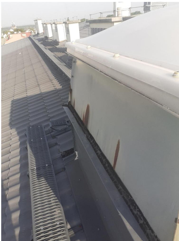
Do malowania obróbki blacharskie świetlików
