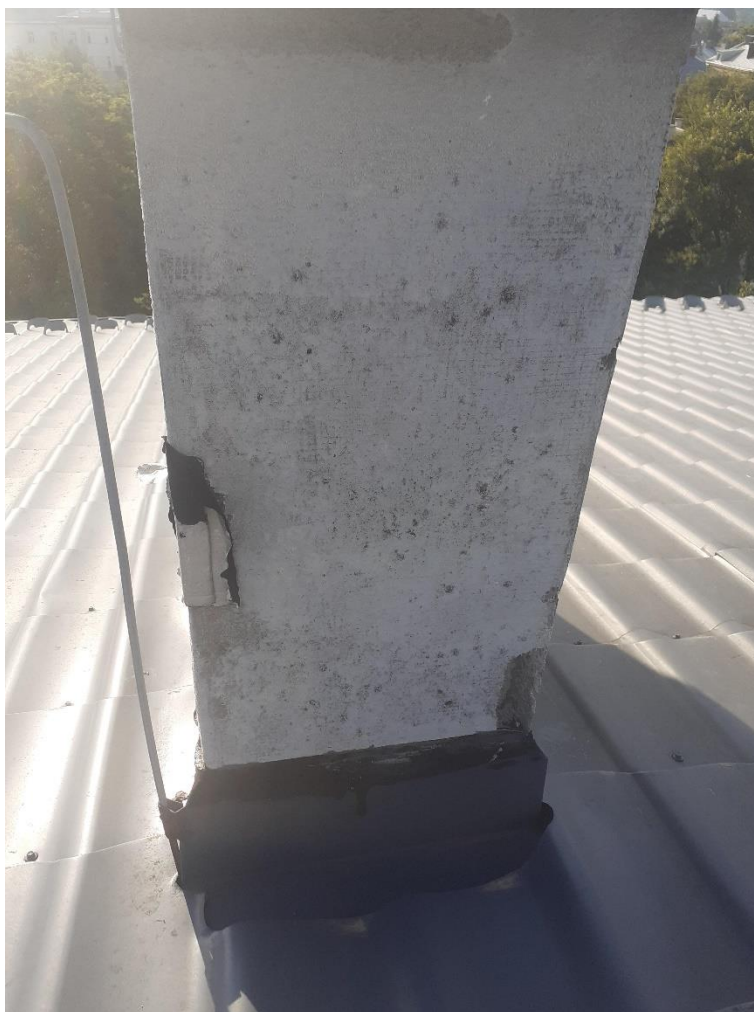
Nowa wyprawa elewacyjna na kominach, obróbki blacharskie
