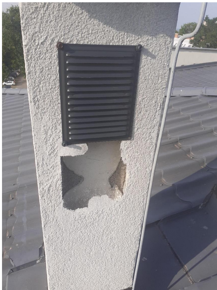
Do uzupełnienia i malowania wyprawa elewacyjna kominów.
