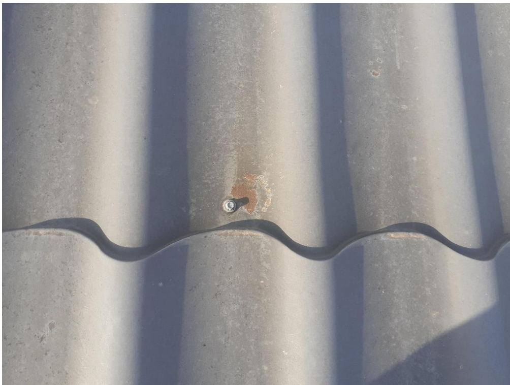
Korozja pokrycia dachowego
