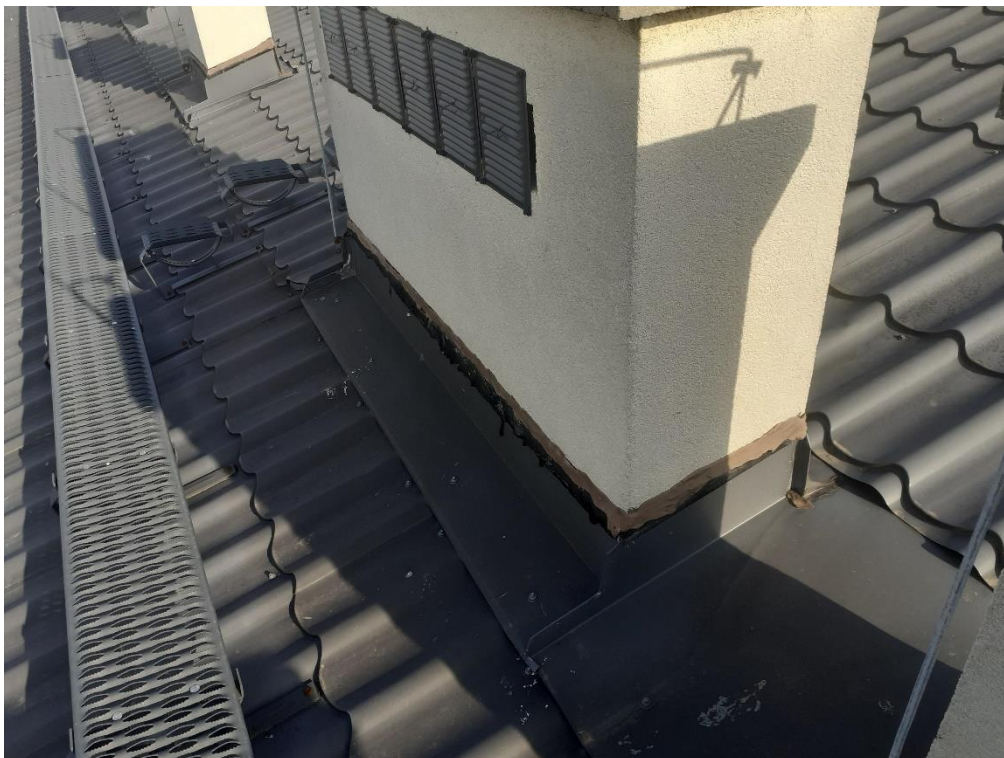
Wykonanie nowych obróbek przy kominach z wcięciem
