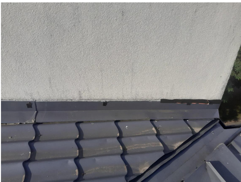
Wykonanie nowych obróbek przy kominach z wcięciem
