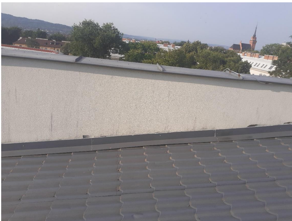
Naprawa wyprawy attyki, malowanie attyki, wykonanie nowych obróbek blacharskich (z wcięciem).
