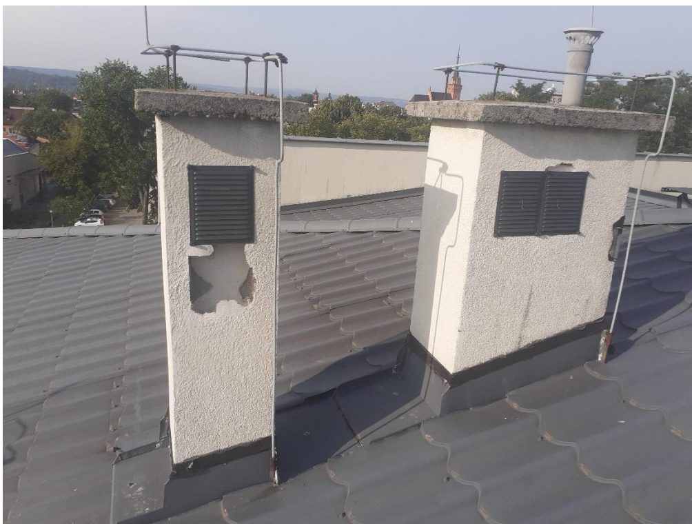
Do uzupełnienia i malowania wyprawa elewacyjna kominów.
