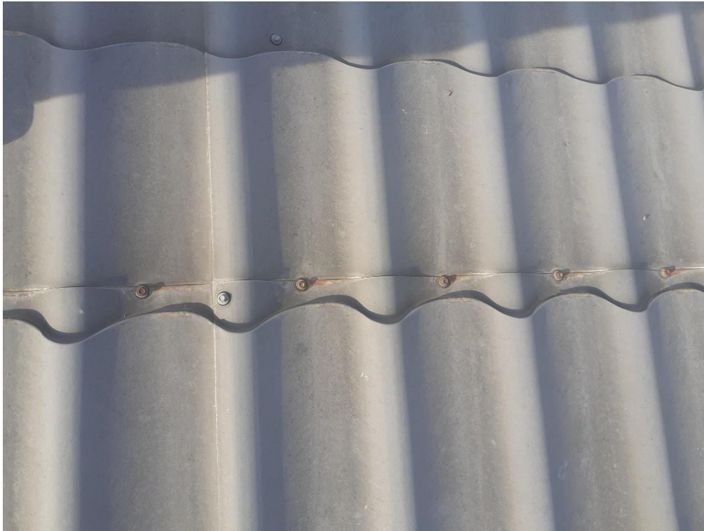
Korozja pokrycia dachowego
