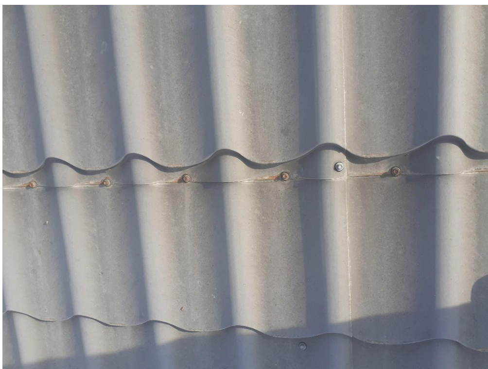
Korozja pokrycia dachowego
