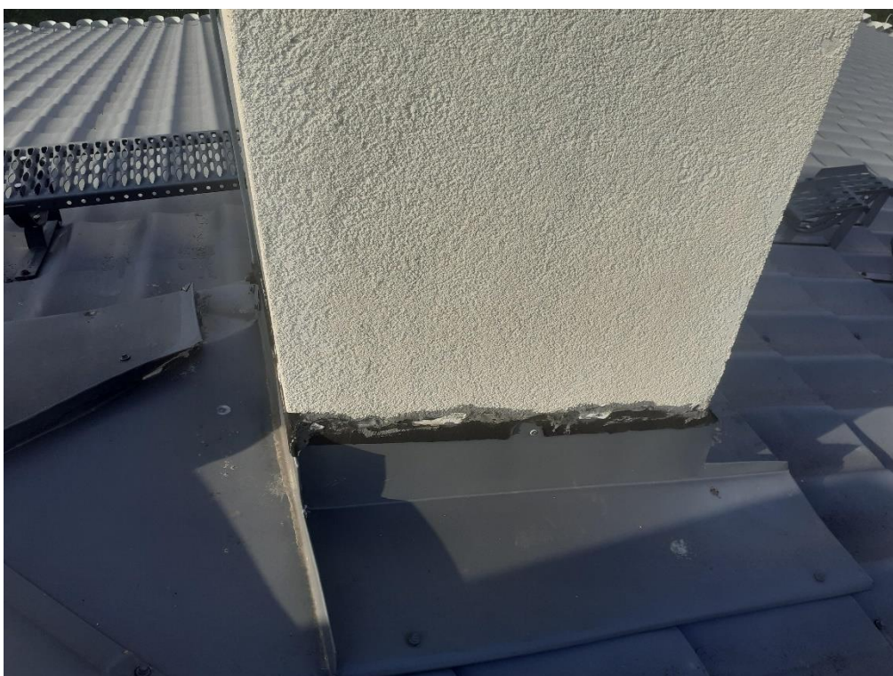
Wykonanie nowych obróbek przy kominach z wcięciem
