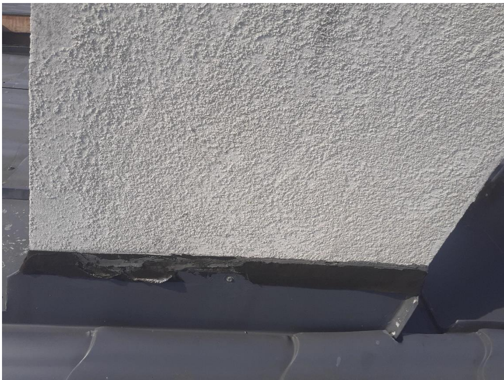
Wykonanie nowych obróbek przy kominach z wcięciem
