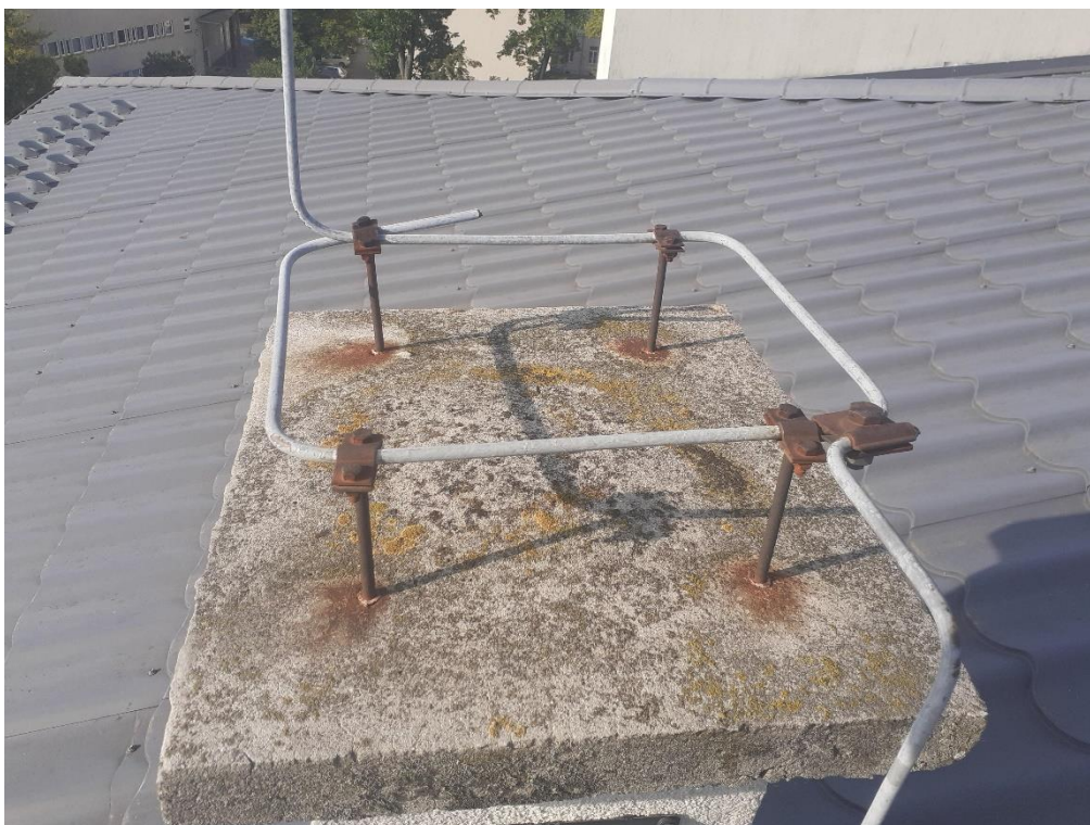
Czyszczenie i malowanie „czapki” kominowej farbą do betonu, malowanie wsporników instalacji odgromowej, wymiana skorodowanych złączek instalacji odgromowej
