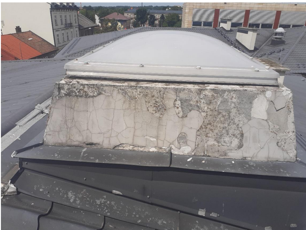
Podstawa świetlika do wykonania nowa wyprawka budynek C
