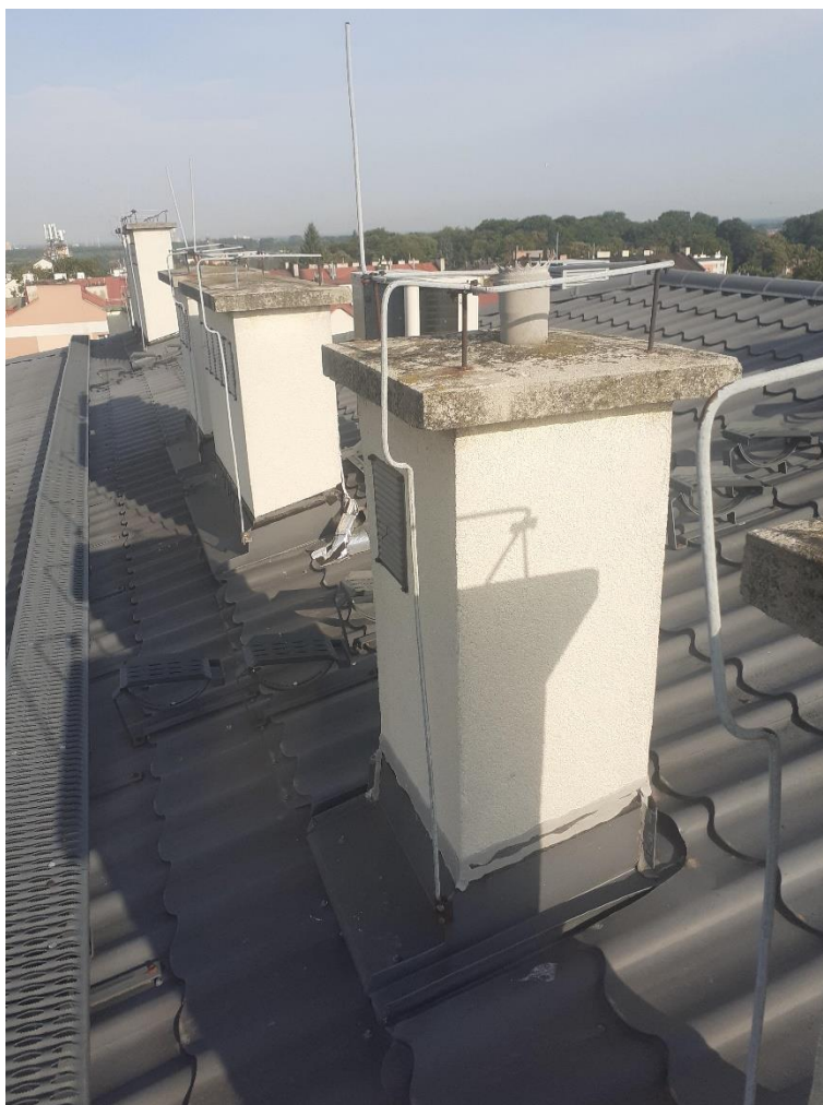
Wykonanie nowych obróbek przy kominach z wcięciem
