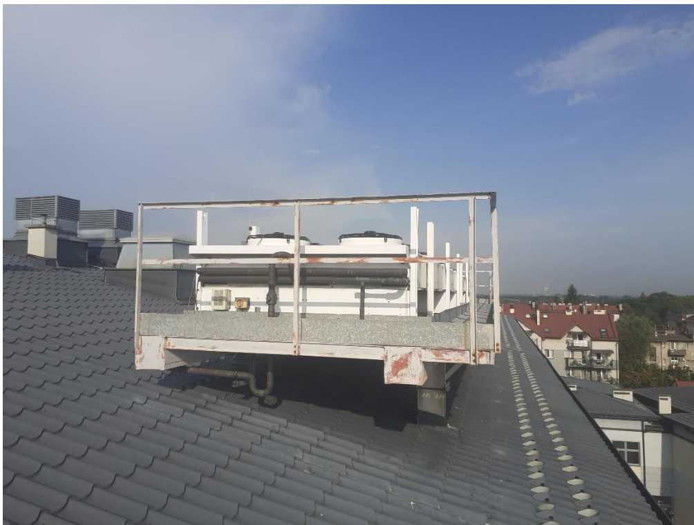
Malowanie konstrukcji wsporczej stalowej
