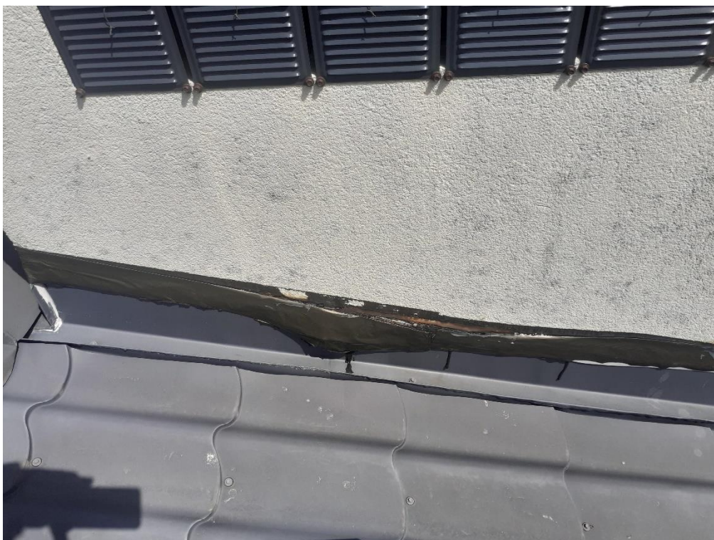
Wykonanie nowych obróbek przy kominach z wcięciem
