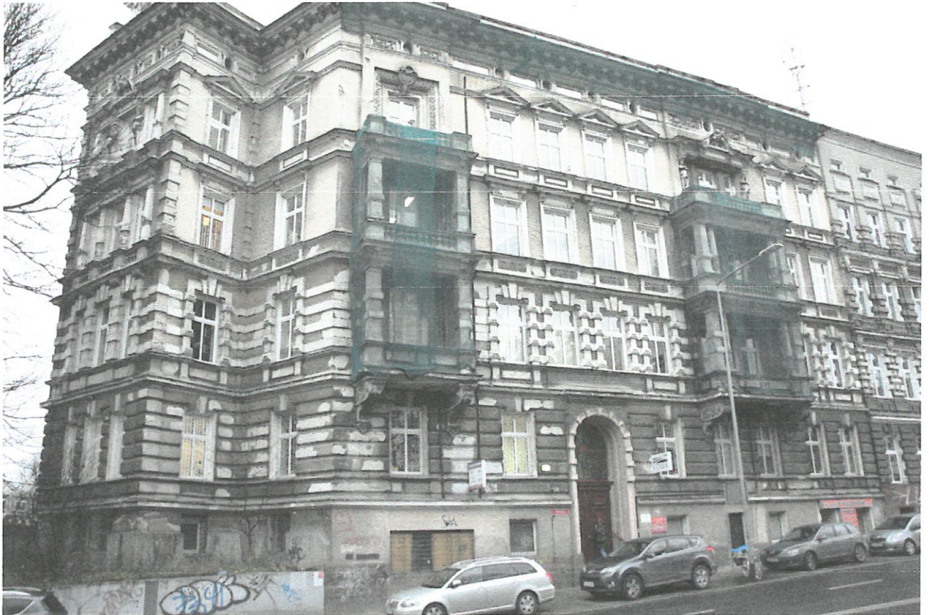
Elewacja frontowa od strony ul. Jana Matejki – widoczne liczne ubytki tynku i zabezpieczenia balkonów.
