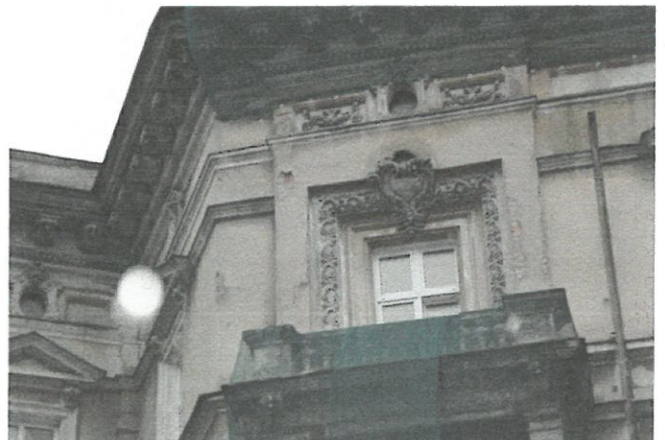
Liczne ubytki tynku w strefach nadprożowych.
