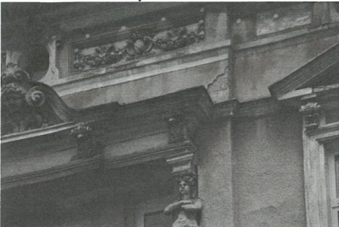
Liczne ubytki tynku w strefach nadprożowych.
