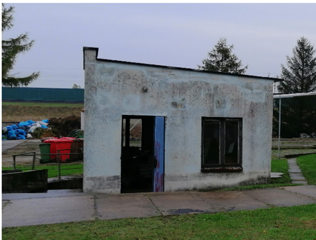
Fot.3. Budynek pompowni ścieków
