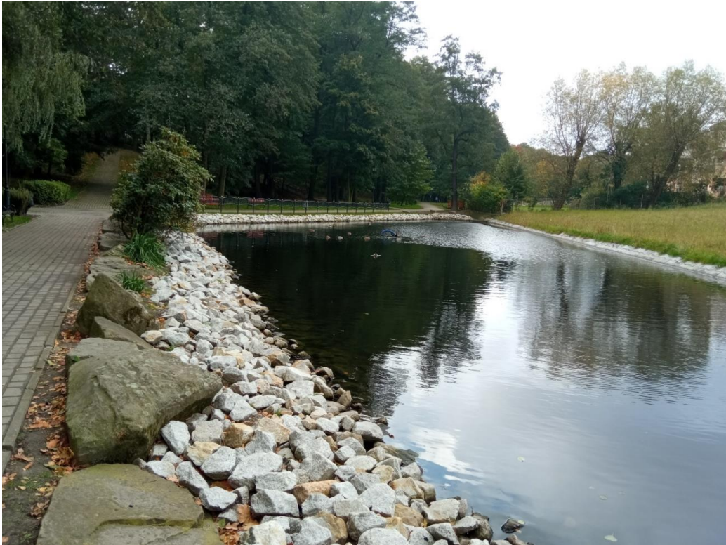
Fot. 3 Umocnienie brzegu – narzut kamienny
