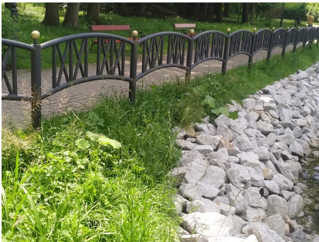
Fot. 6 Pas powyżej narzutu kamiennego do obsadzenia
