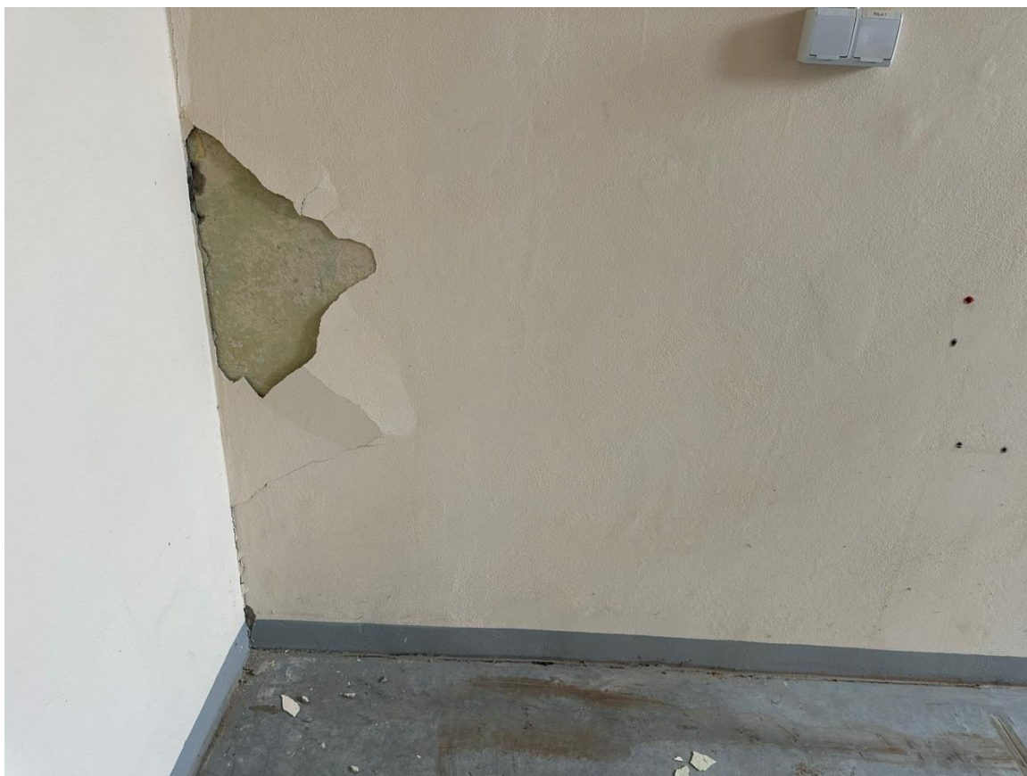
Zdjęcie 6. Spękania i uszkodzenia powłok malarskich
