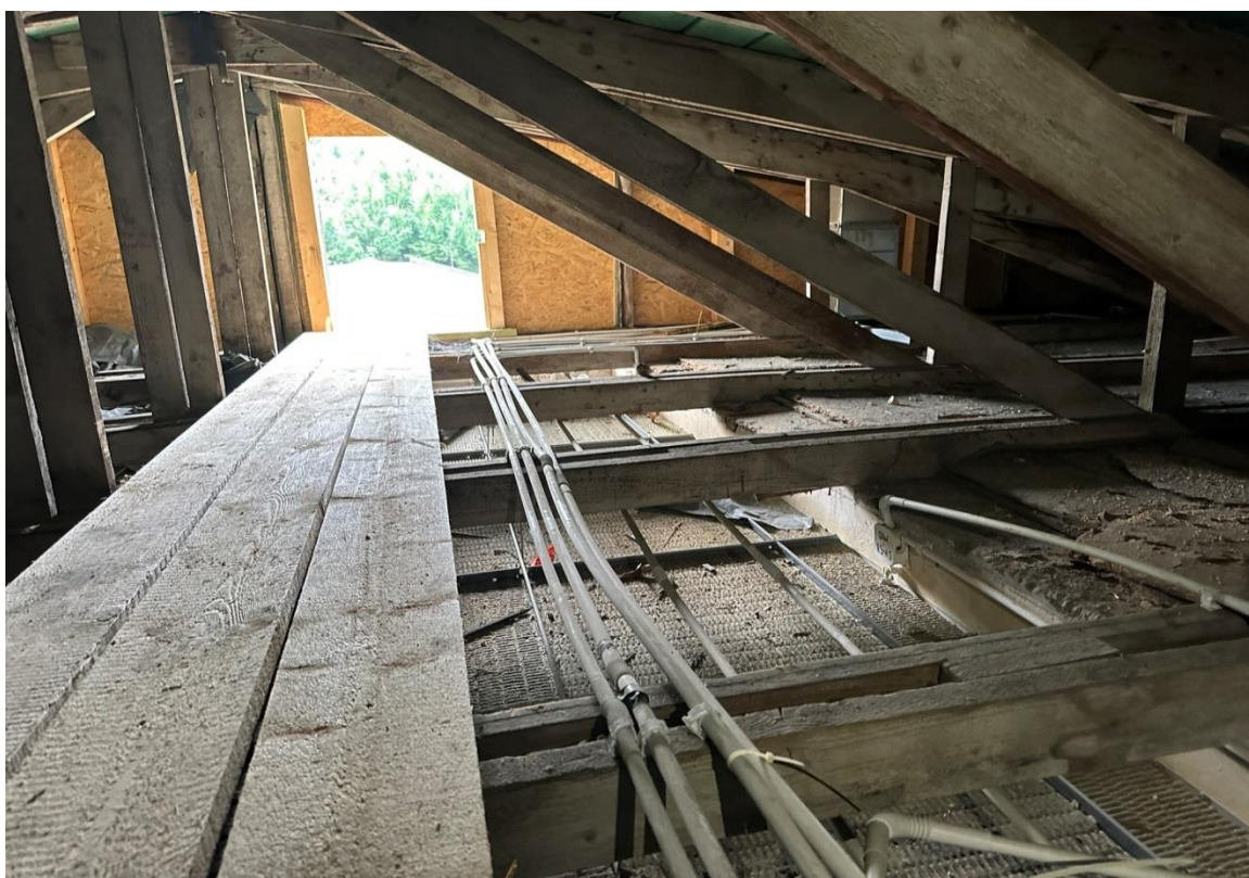
Zdjęcie 5. Konstrukcja drewniana dachu
