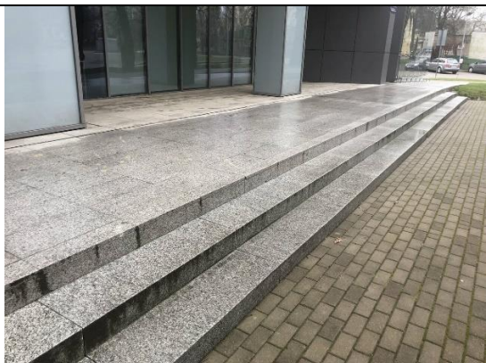
Fot. 2. Schody wejściowe od frontu budynku
