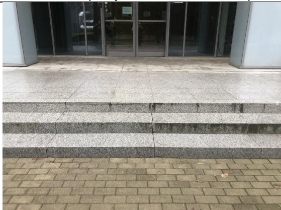
Fot. 4. Schody wejściowe od frontu budynku
