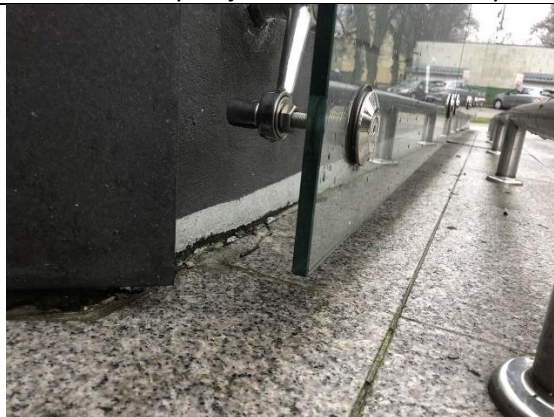
Fot. 5. Szyby na elewacji budynku
