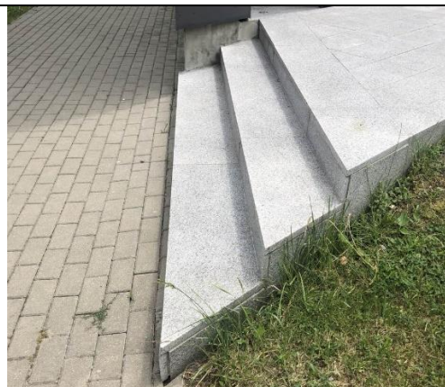
Fot. 3. Schody wejściowe od frontu budynku
