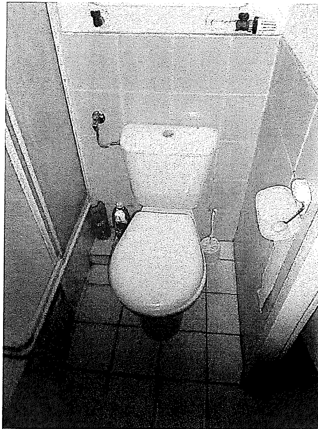
Fot. 3. Stan istniejący – widok na kompakt wc
