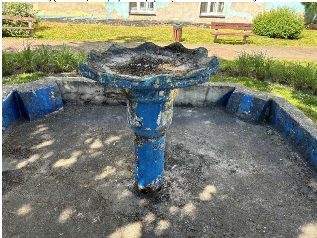
Zdjęcie nr 6, Widok na zdegradowany słup fontanny bez dysz
