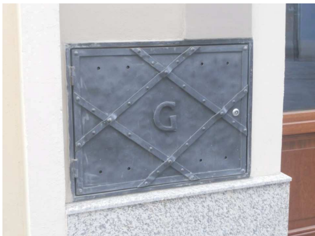
Zdj. 84 Osłona szafki gazowej, producent Metalcraft Kowalstwo Artystyczne; źródło: http://metalcraft.wroclaw.pl/gallery/drzwiczki-do-skrzynki-gazowej/
