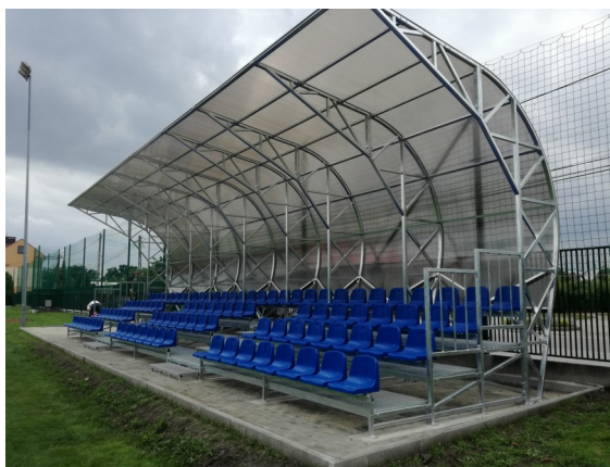
Trybuna modułowa czterorzędowa za zadaszeniem - przykład.
