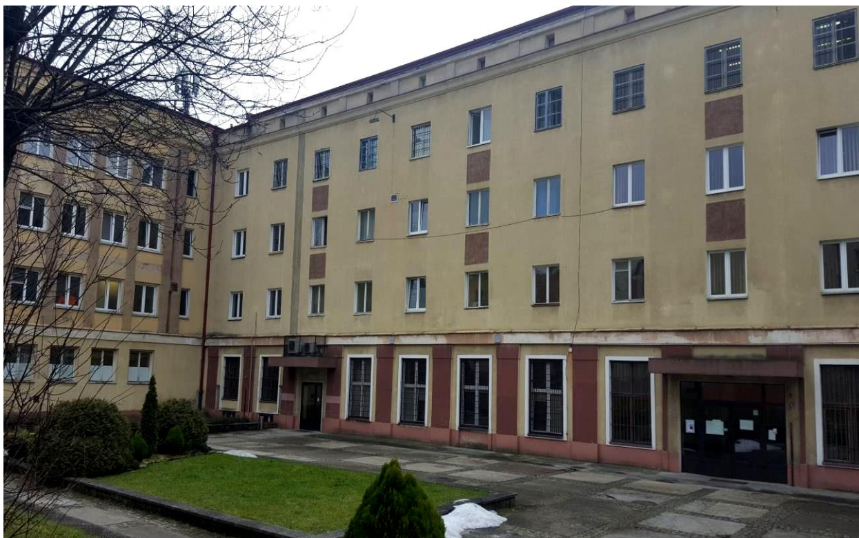
fot.24 Budynek nr 5 AMW przy ul.Śmidowicza w Gdyni., widok na elewacje od strony wewnętrznego dziedzińca.
