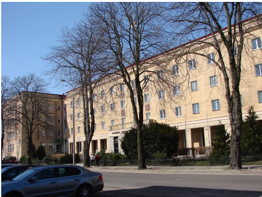
fot.4 Budynek nr 5 AMW przy ul.Śmidowicza w Gdyni., widok na elewację południową (od strony wschodniej).
