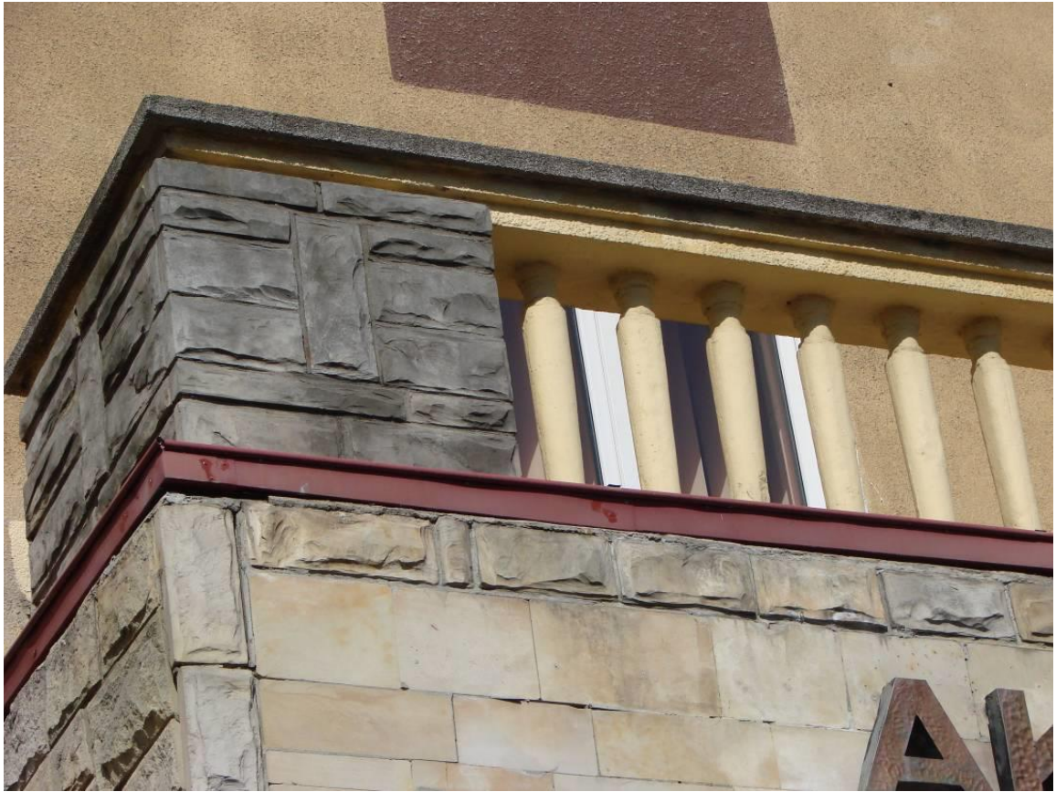
fot.10 -12 Okładzina portyku, poniżej stan zachowania tarasu, widoczne uszkodzenia okładzin i tralek
