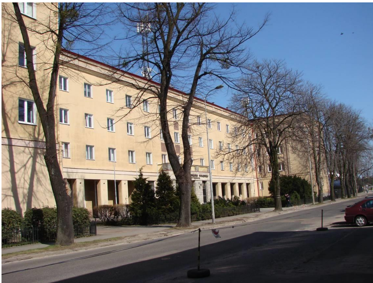
fot.3 Budynek nr 5 AMW przy ul.Śmidowicza w Gdyni., widok na elewację południową (od strony zachodniej).
