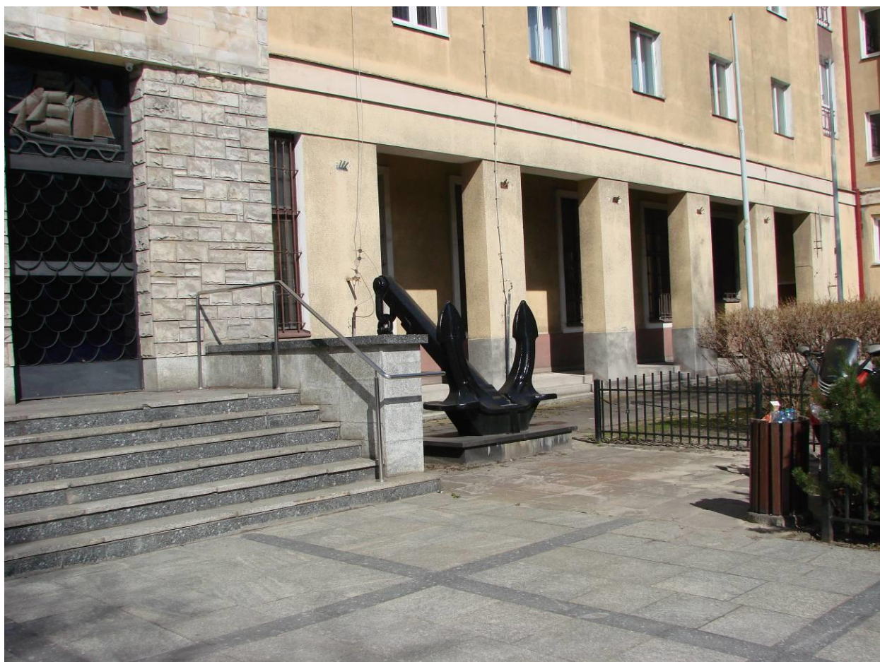
fot.9 Podest i stopnie głównego wejścia.
