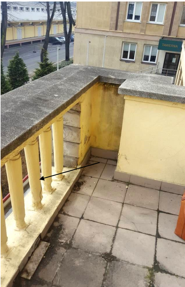
fot.10 -12 Okładzina portyku, poniżej stan zachowania tarasu, widoczne uszkodzenia okładzin i tralek
