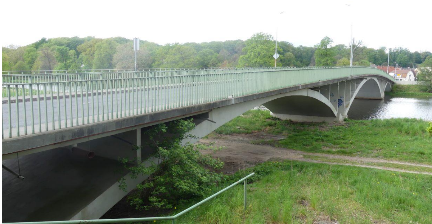
Fot. 3 Widok mostu z boku
