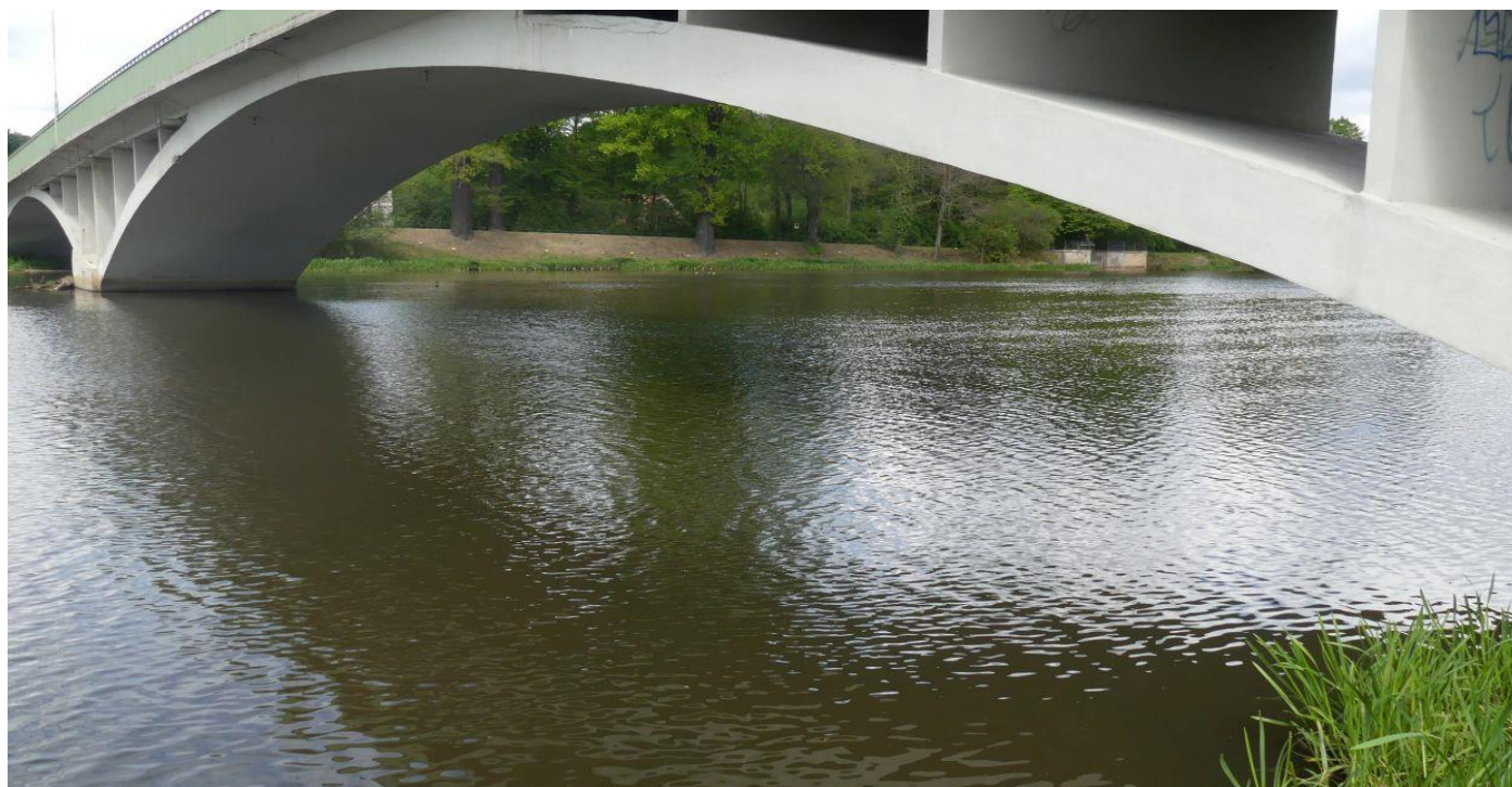
Fot. 6 Widok przestrzeni podmostowej
