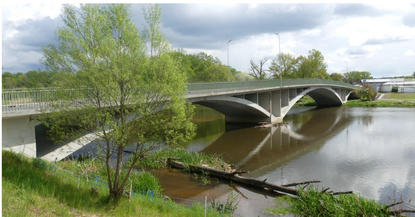
Fot. 4 Widok mostu z boku
