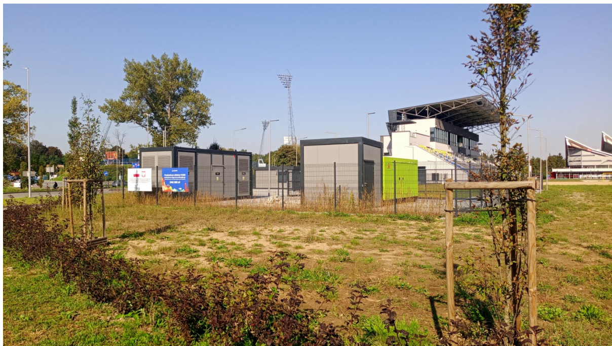
7. Strefa techniczna (agregat prądowórczy, rozdzielnia główna, stacja trafo).[1]
