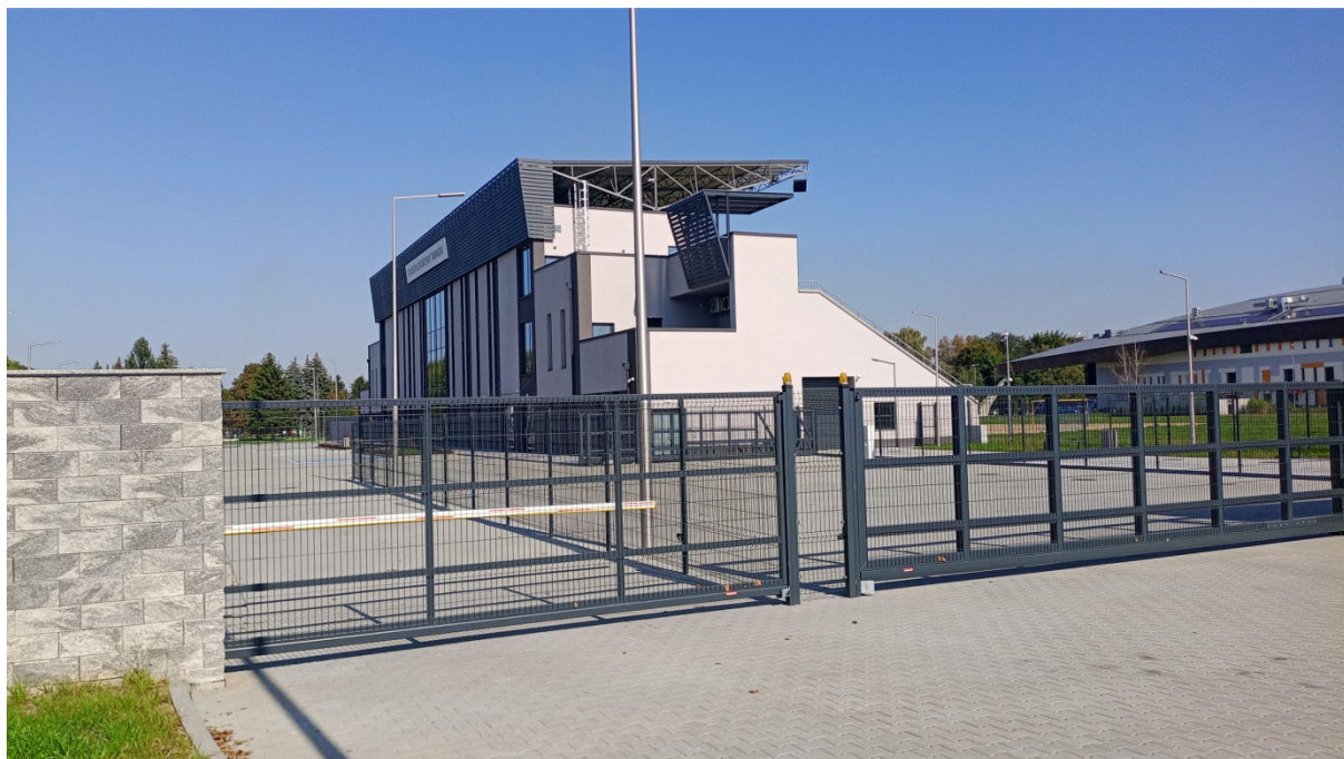
5. Trybuna główna - widok od strony północnej. Istniejące ogrodzenie.
