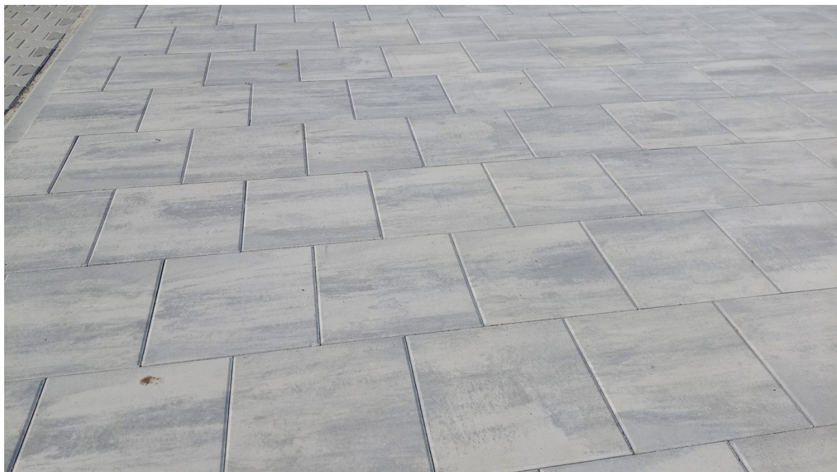
6. Istniejące nawierzchnie ruchu pieszego.
