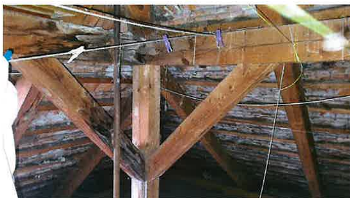
Fot. 10 Wieżba dachowa
