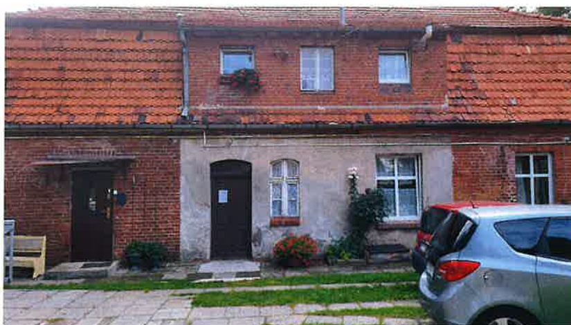
Fot. 3 Elewacja zachodnia, wejścia do budynku
