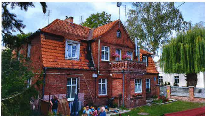
Fot. 2 Elewacja południowo – wschodnia
