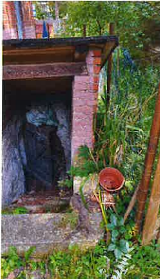
Fot. 6 Zejście zewnętrzne do piwnicy
