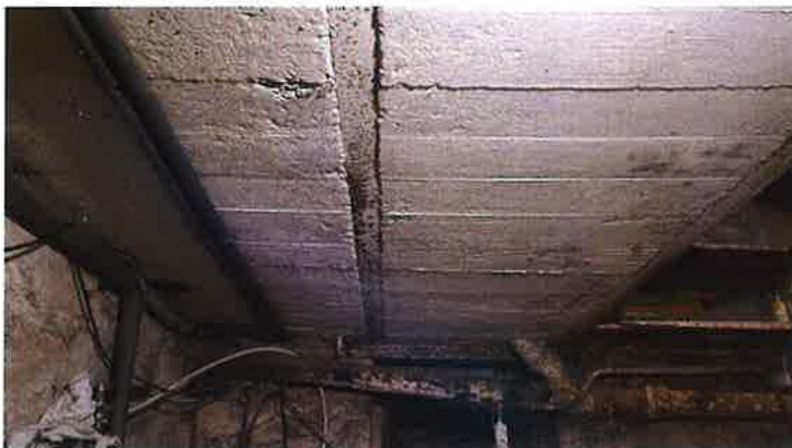
Fot. 20 Strop nad piwnicą
