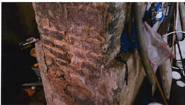
Fot. 21 Ściana wewnętrzna piwnicy
