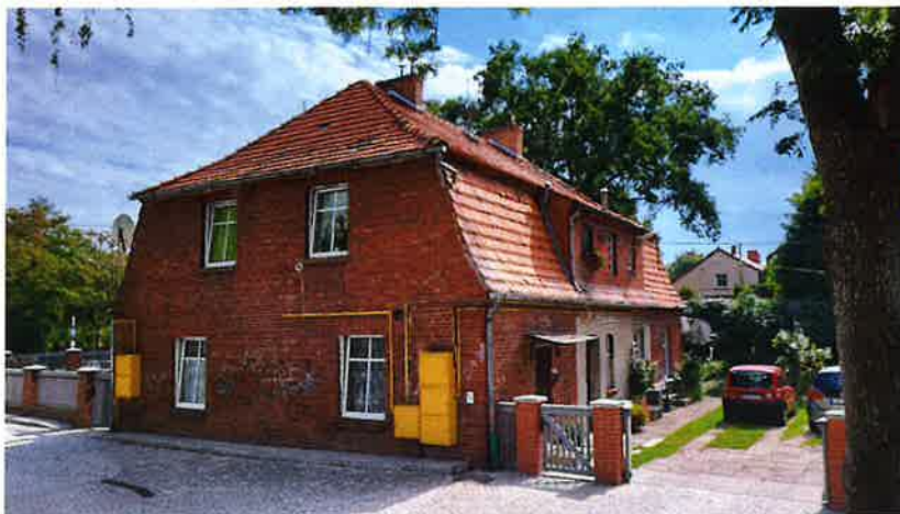
Fot. 1 Elewacja północno – zachodnia
