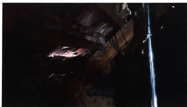
Fot. 12 Ubytek w poszyciu dachowym
