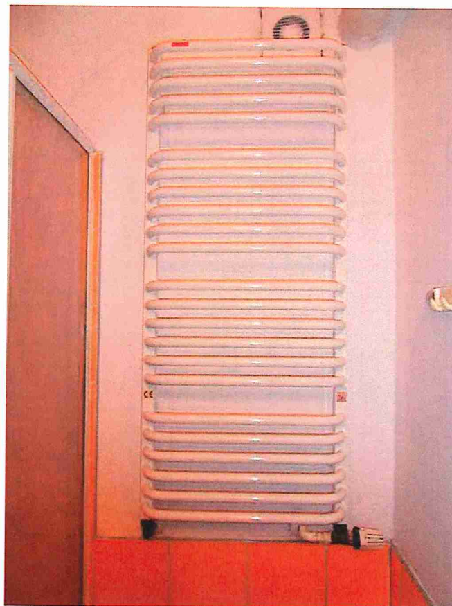
Fot. 4. Stan istniejący – widok na grzejnik
