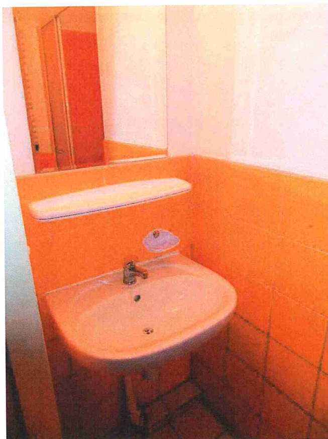
Fot. 2. Stan istniejący – widok na umywalkę
