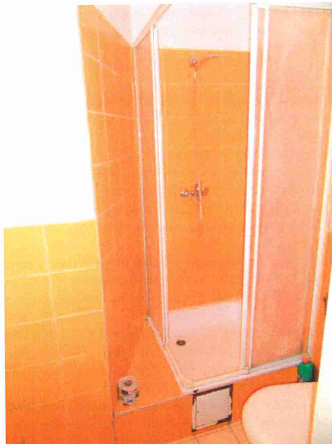
Fot. 1. Stan istniejący – widok na kabinę prysznicową
