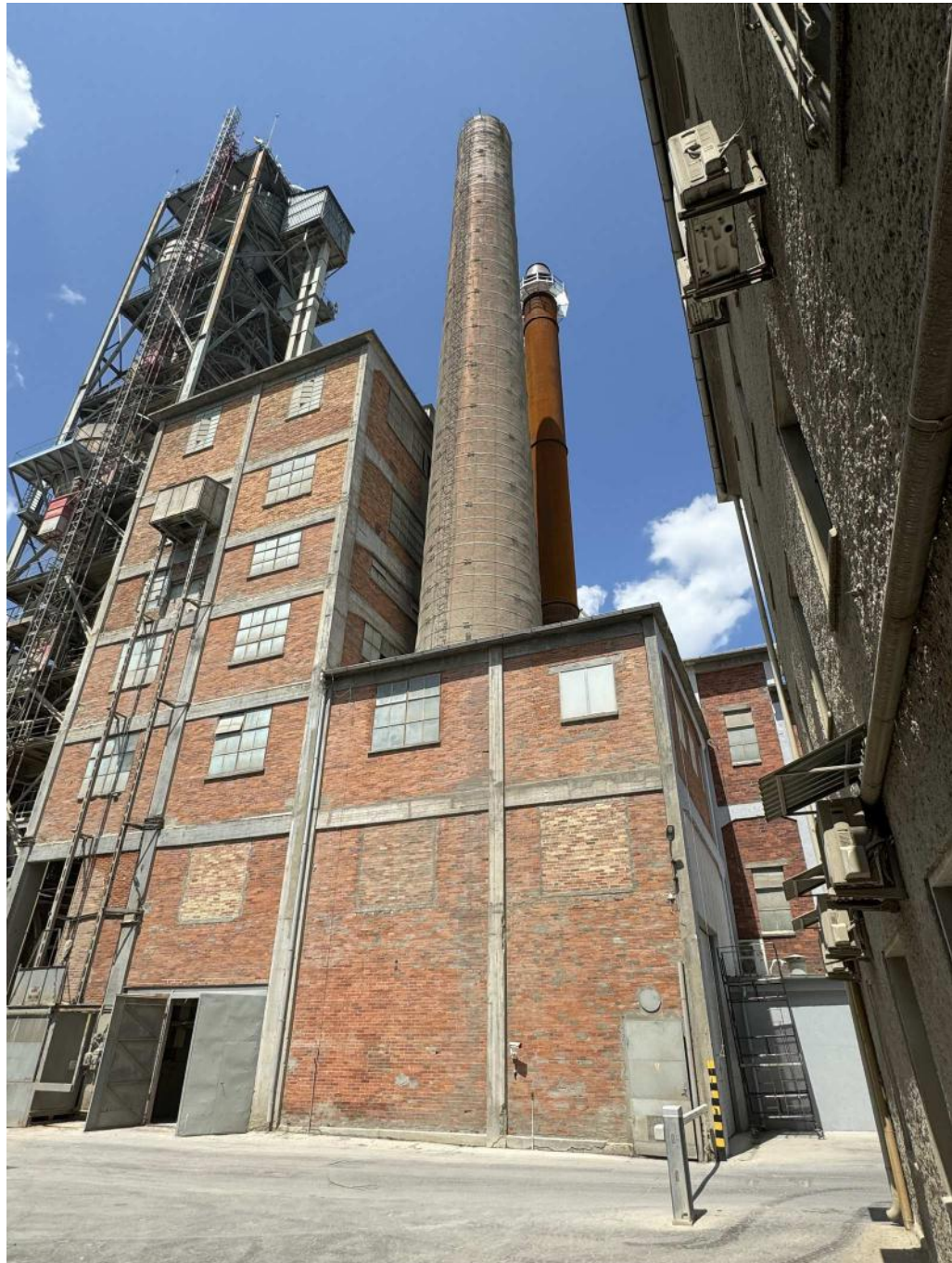
Fot. 1. Widok ogólny kolina od południa (w tle nowy komin)
