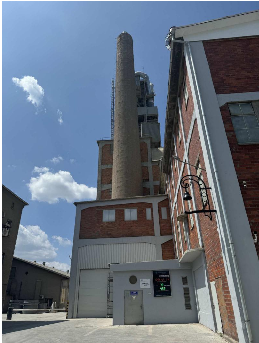
Fot. 2. Widok komina od wchodu
