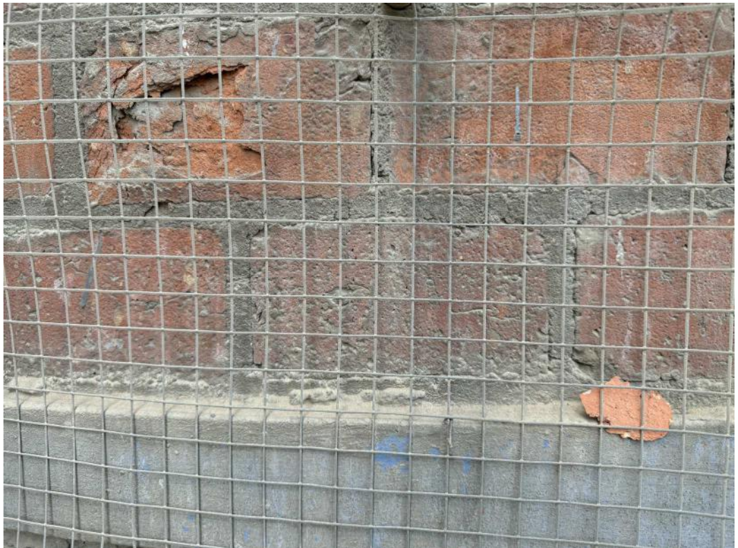
Fot. 41. Osiatkowanie komina ciągłe, bez uszkodzeń wystających odłamki
