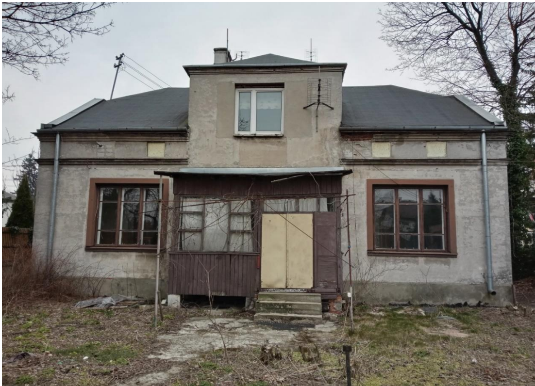
Fot.1. Budynek do wyburzenia
