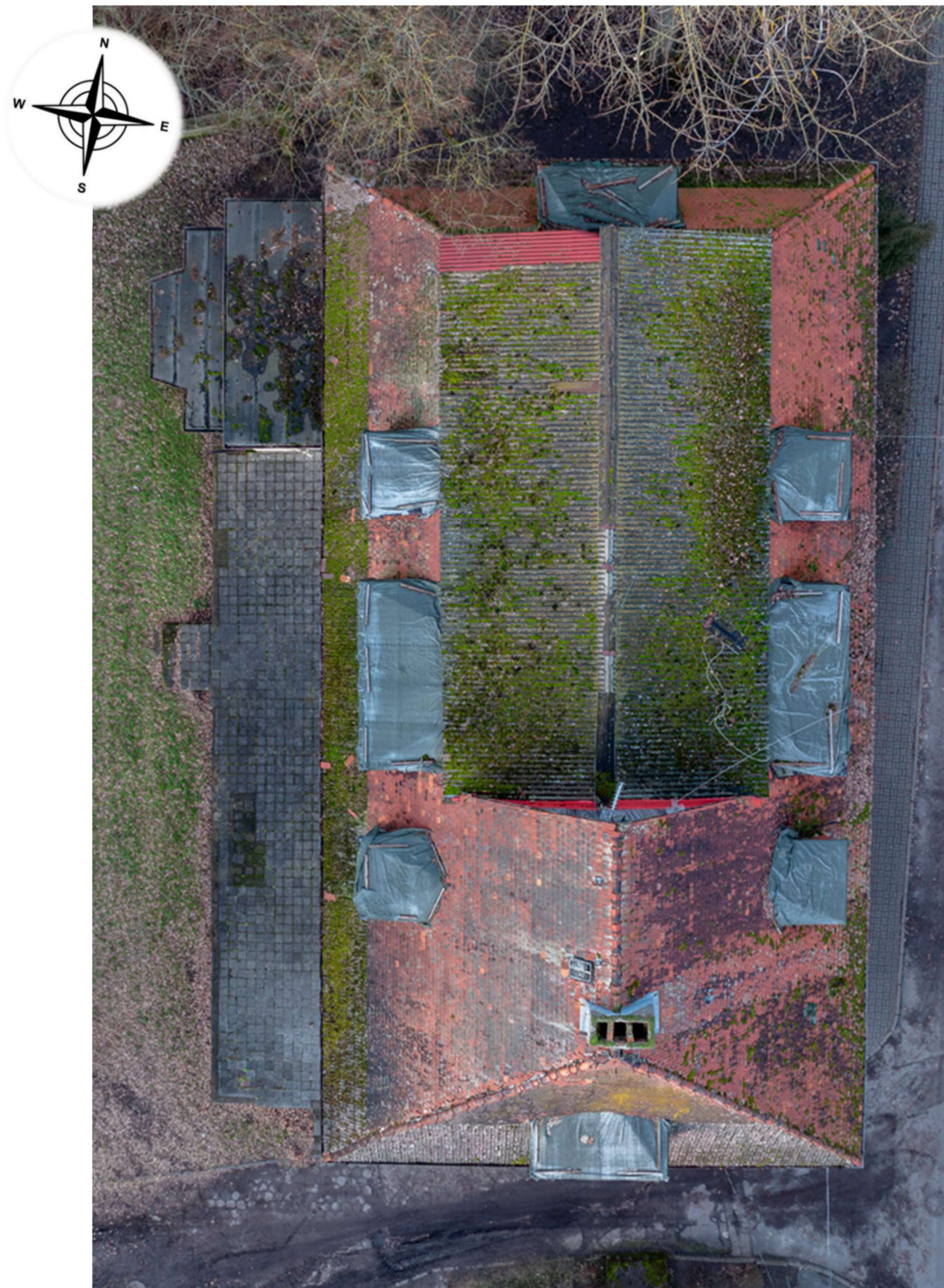
Widok całego dachu od góry
