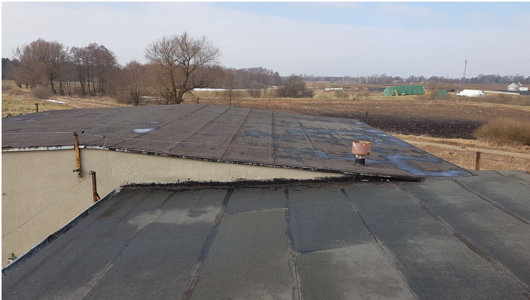
Fot. 3. Dach budynku technologicznego
