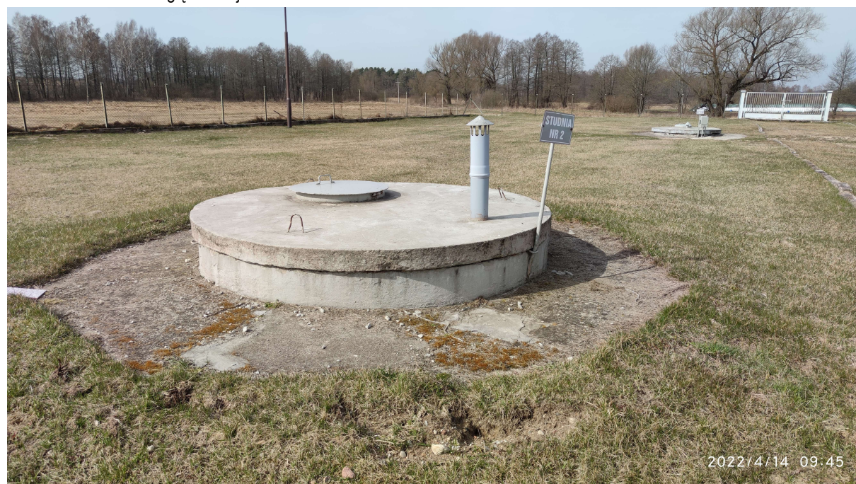
Fot. 8 Obudowa studni głębinowej nr 2
