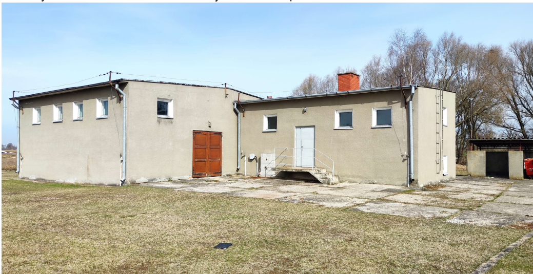
Fot. 1. Budynek SUW Niedźwiedzkie – elewacja wschodnia i południowa
