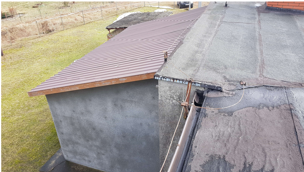
Fot. 4. Zadaszenie pomieszczenia agregatu
