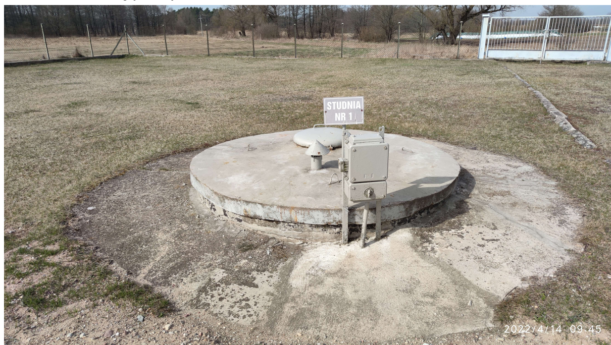
Fot. 7. Obudowa studni głębinowej nr 1
