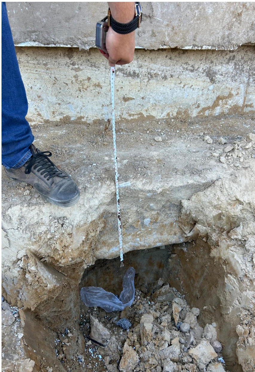
Fot. nr 1 Widok na fundamenty istniejącej szkoły w miejscu projektowanego łącznika
