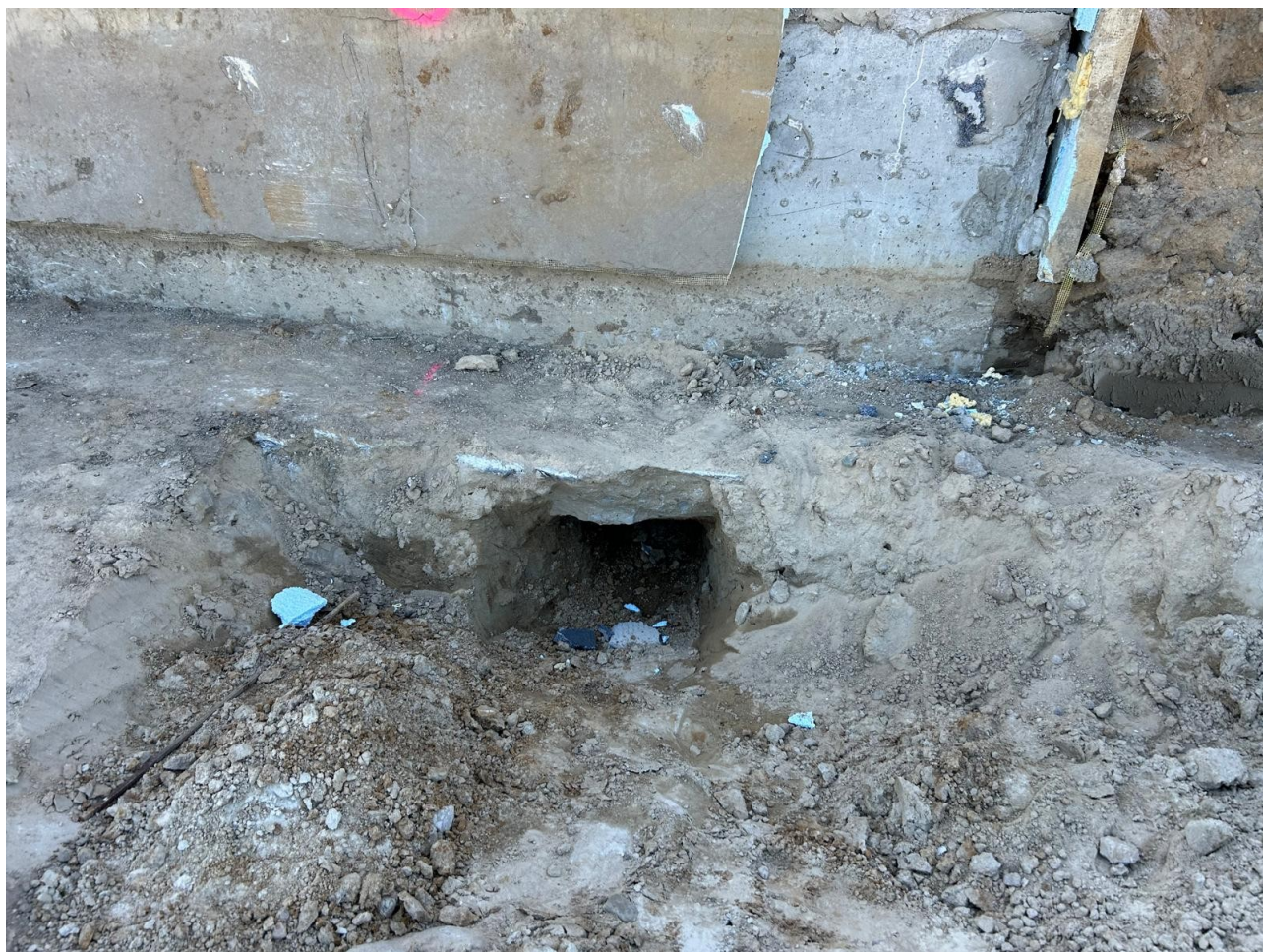
Fot. nr 3 Widok na fundamenty istniejącej szkoły w miejscu projektowanego łącznika
