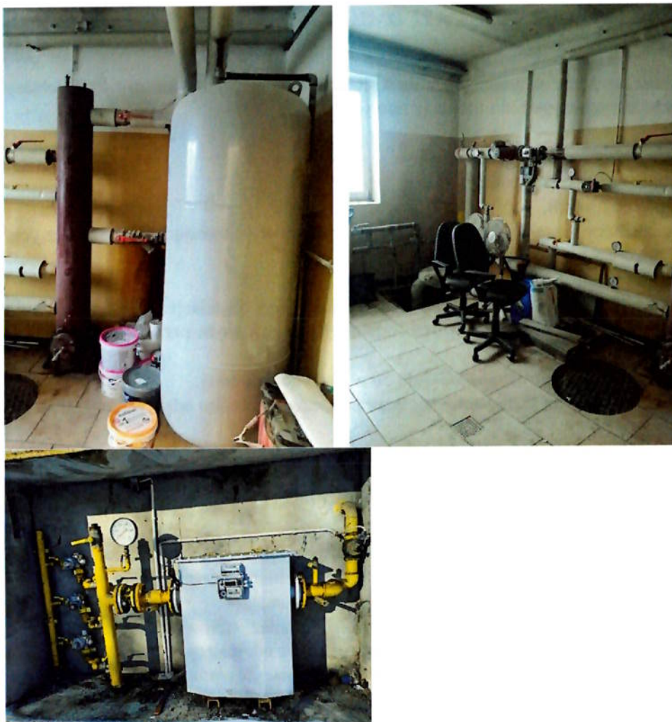
Rys. 1 Istniejąca kotłownia i istniejące pomieszczenie rozdzielaczy.
