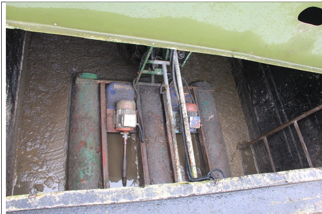
Zdjęcie. Widok starego urządzenia napowietrzająco-mieszającego
