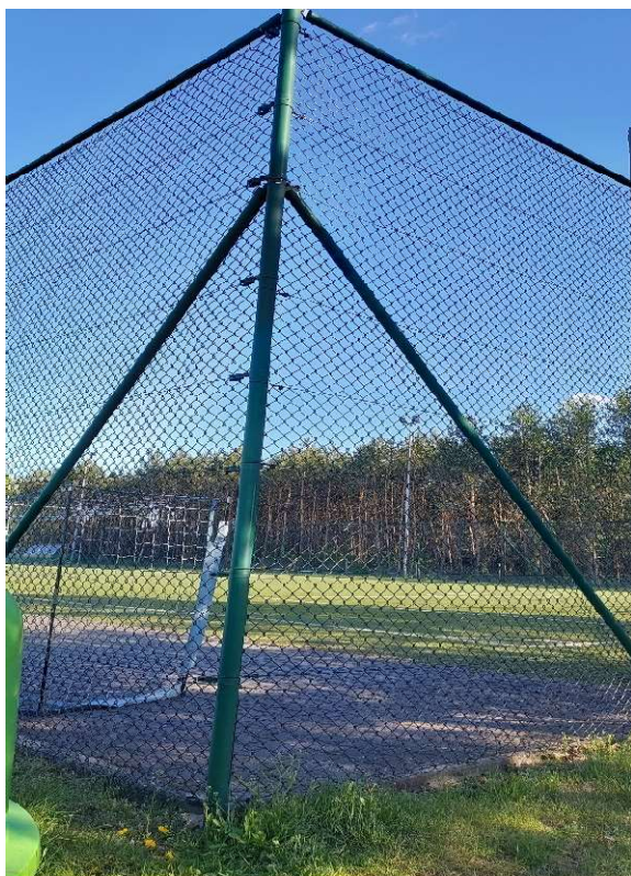
Rys. 27. Istniejące ogrodzenie orlika, do którego należy nawiązać nowe ogrodzenie infrastruktury sportowej.
