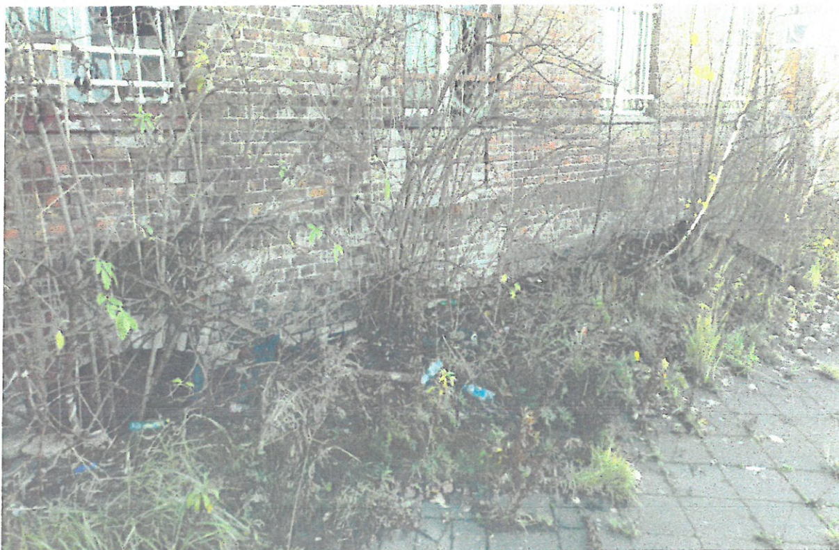
Zdjęcie nr 10 – okna w poziomie piwnicy
