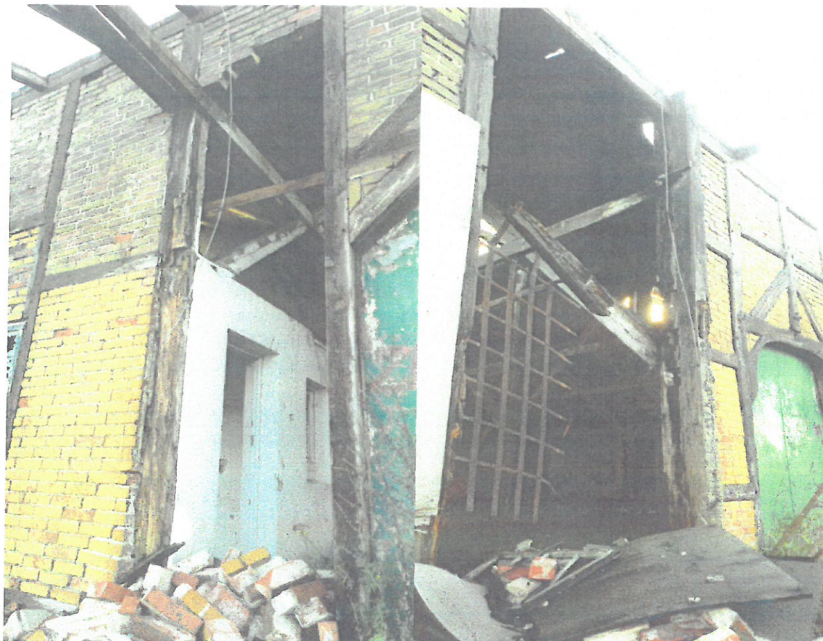
Zdjęcie nr 23, 24 – zniszczone kwatery i konstrukcja drewniana ściany szachulcowej
