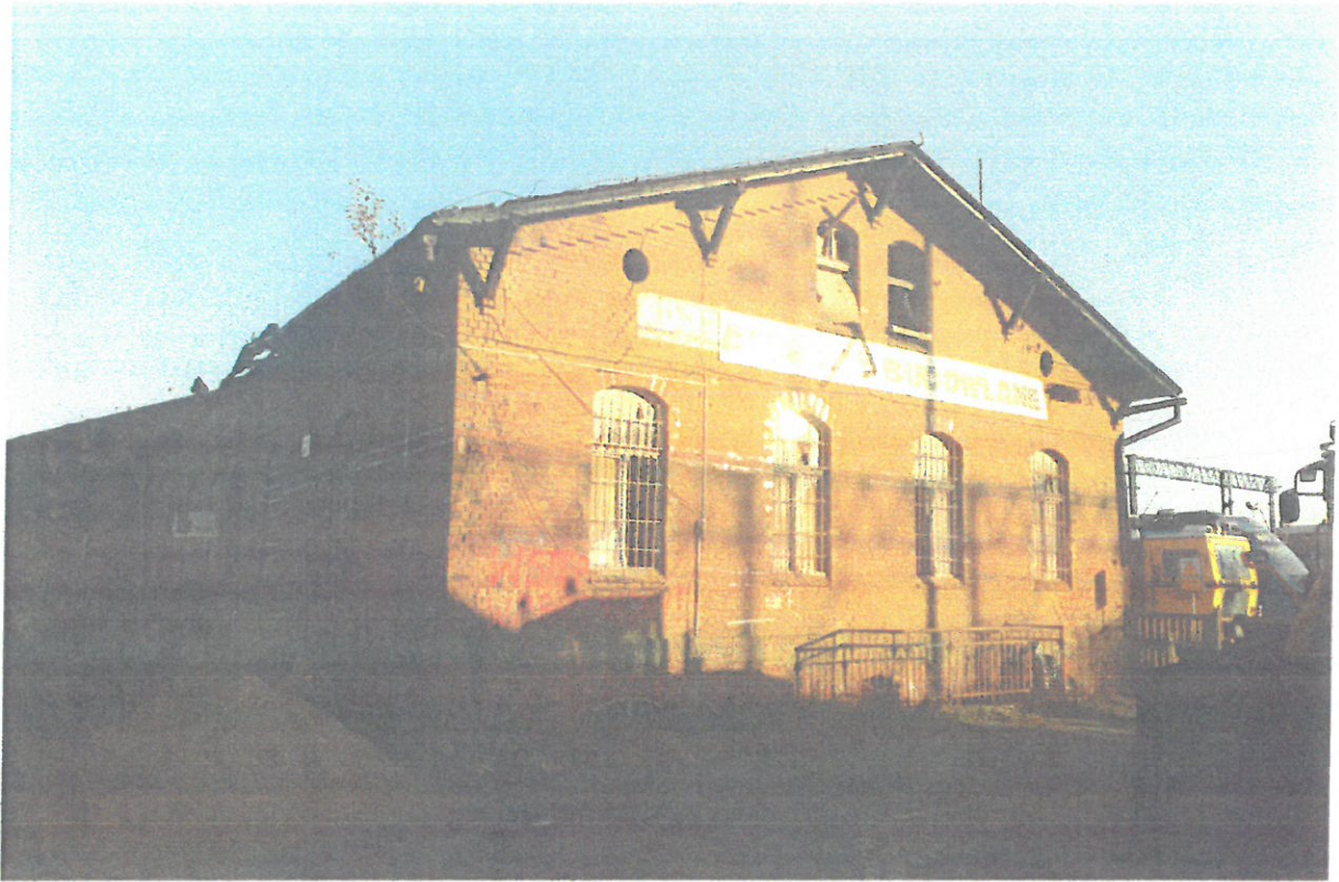
Zdjęcie nr 1- Elewacja szczytowa od strony południowej
