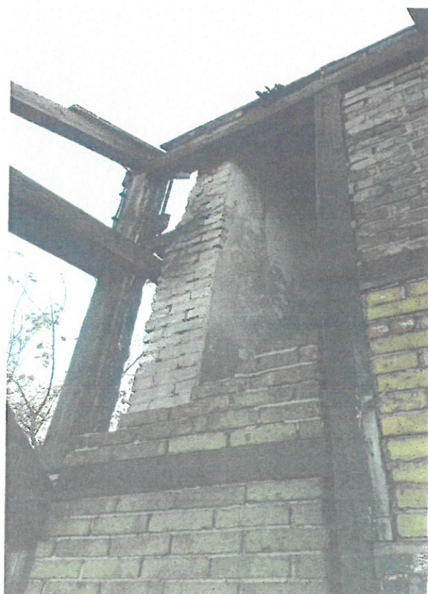
Zdjęcie nr 23, 24 – zniszczone kwatery i konstrukcja drewniana ściany szachulcowej
