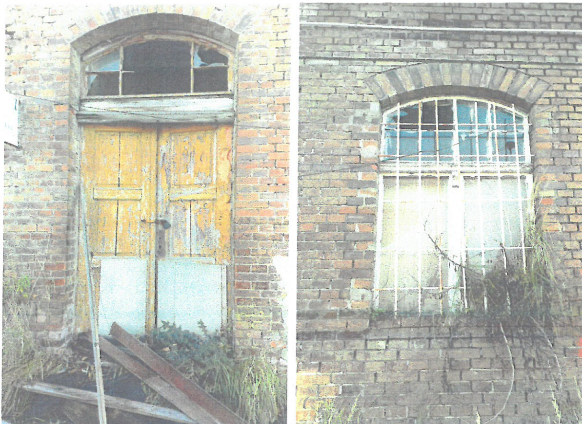
Zdjęcie nr 3, 4- stolarka okienne i drzwiowa
