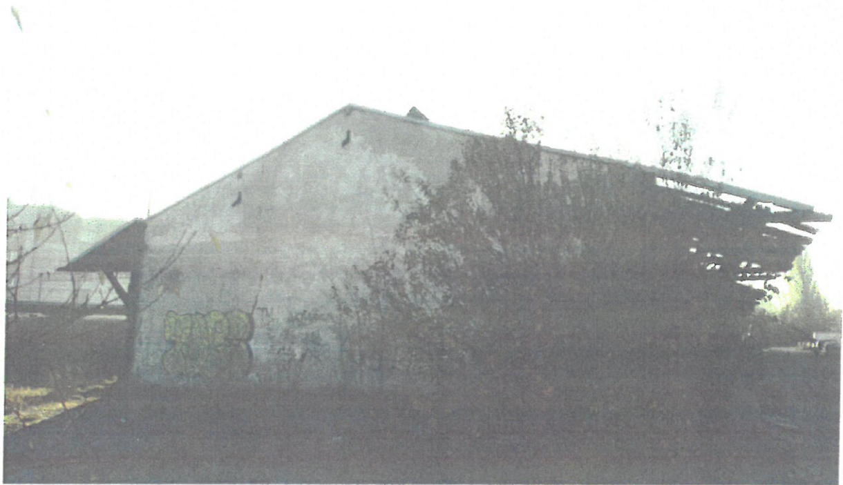
Zdjęcie nr 19 – murowana ściana szczytowa
