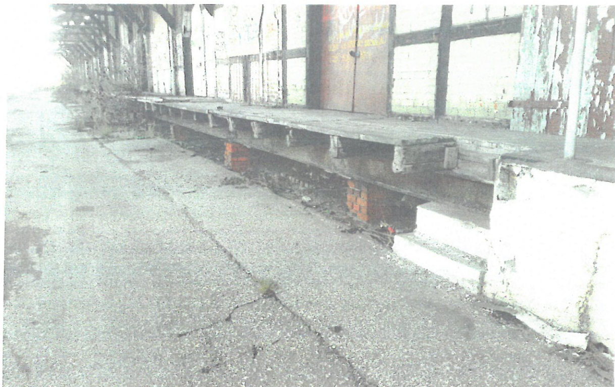
Zdjęcie nr 14 – konstrukcja rampy na belce stalowej
