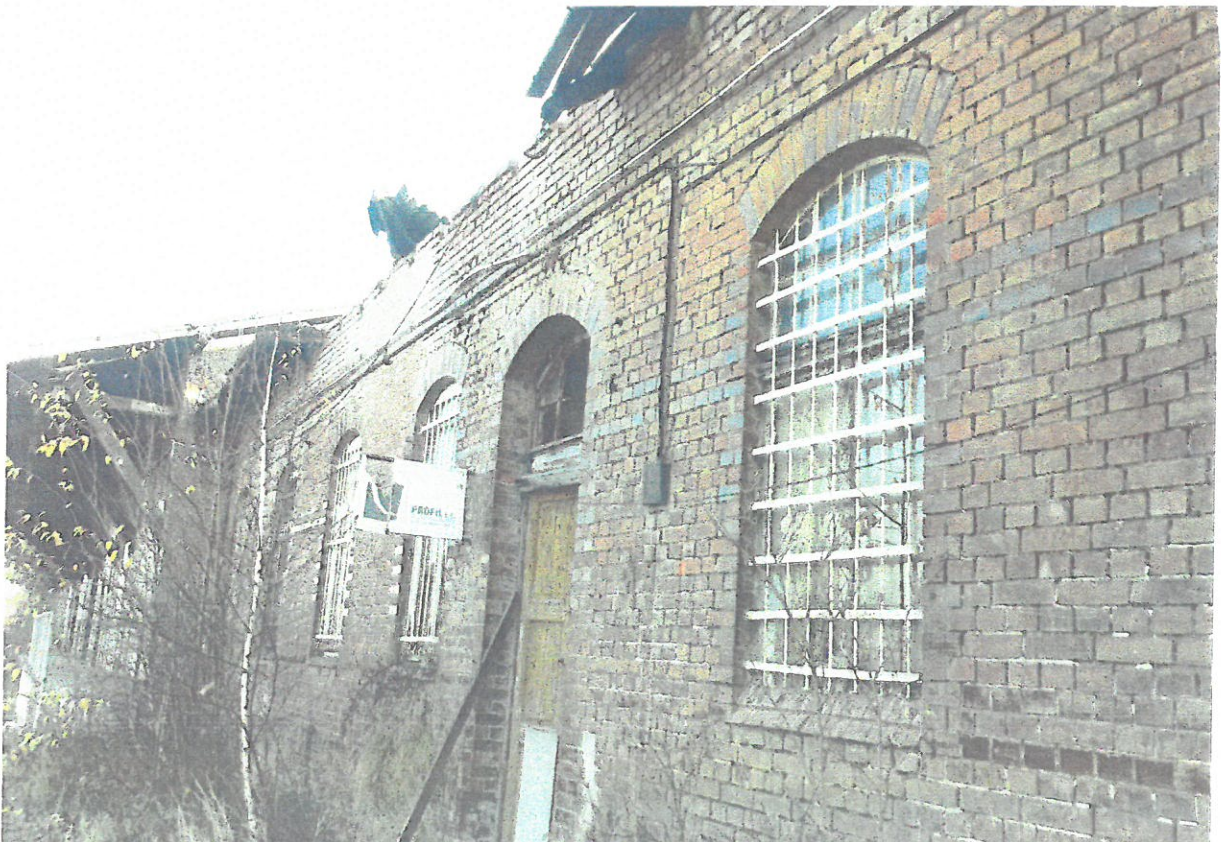
Zdjęcie nr 2- Elewacja frontowa
