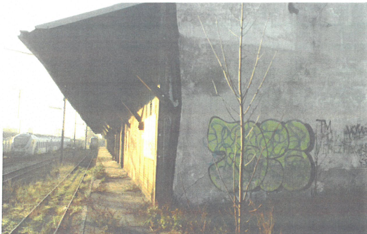
Zdjęcie nr 21 – rampa od strony torów kolejowych
