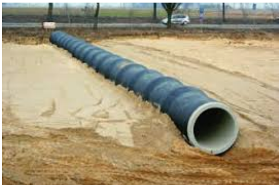
Fot. 6. Zmontowana część przelotowa przepustu
